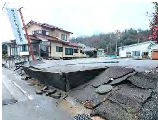
アスファルトがめくれ上がっている。
