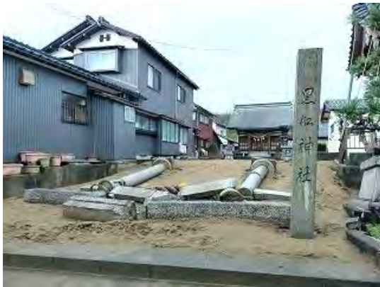
宮坂地区（河北潟の埋立地）の黒船神社及び住宅街における地盤被害 （令和6年1月6日午前撮影）
