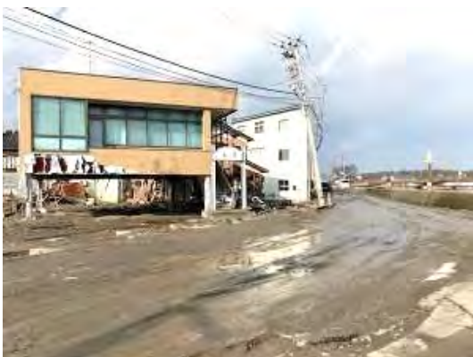
珠洲市役所から徒歩2～3分で津波の跡
