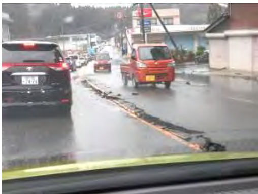
七尾市から穴水町への移動途中 (道路被害と渋滞が続く。救急車の通行も多く、移動に時間を要した。)
