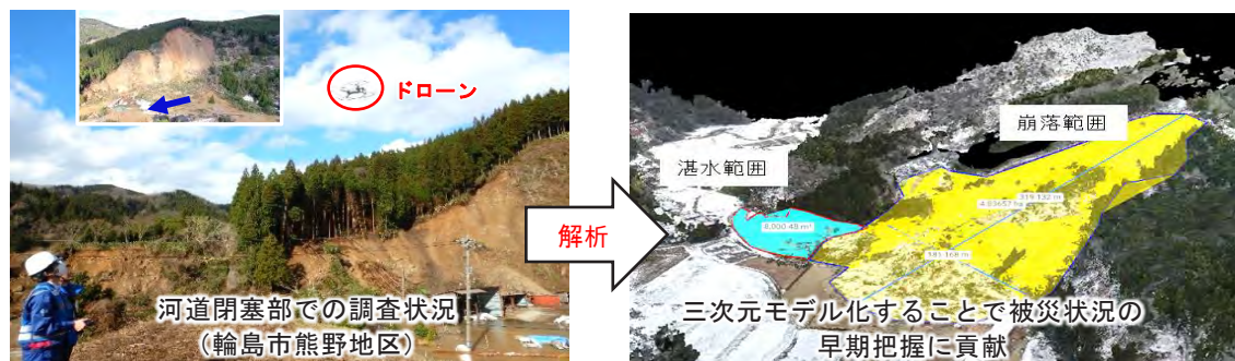
写真4～5 デジタル技術を活用した被災状況の把握事例
