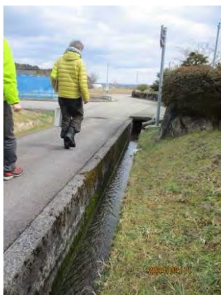
写真9 豊川分館前水路
