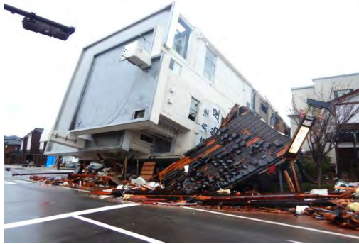
写真3 輪島市内のビル倒壊現場
