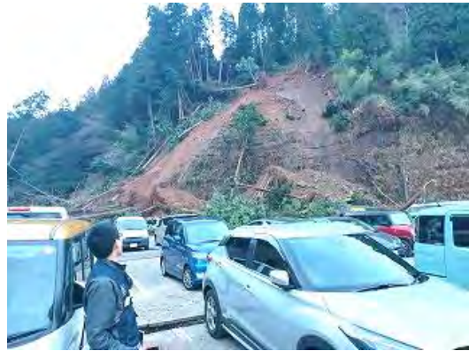
町役場すぐ近くにある山が崩れている。
