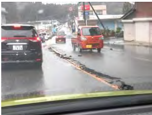
七尾市から穴水町への移動途中 (道路被害と渋滞が続く。救急車の通行も多く、移動に時間を要した。)
