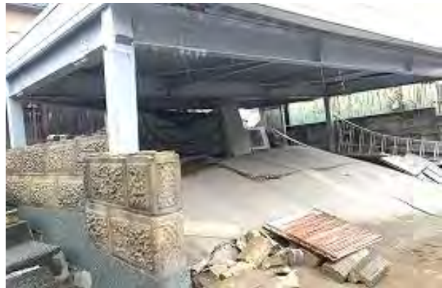
宮坂地区（河北潟の埋立地）の黒船神社及び住宅街における地盤被害（令和6年1月6日午前撮影）
