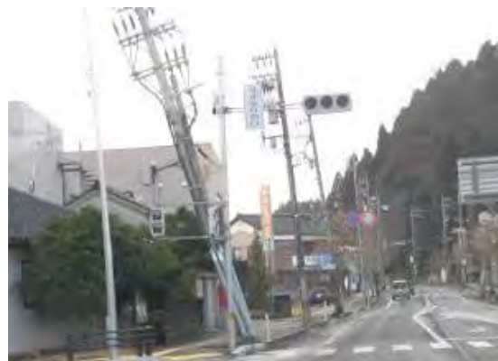
珠洲市内の電柱・信号の損傷
