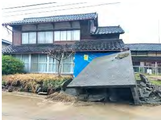
家屋被害玄関先の様子
