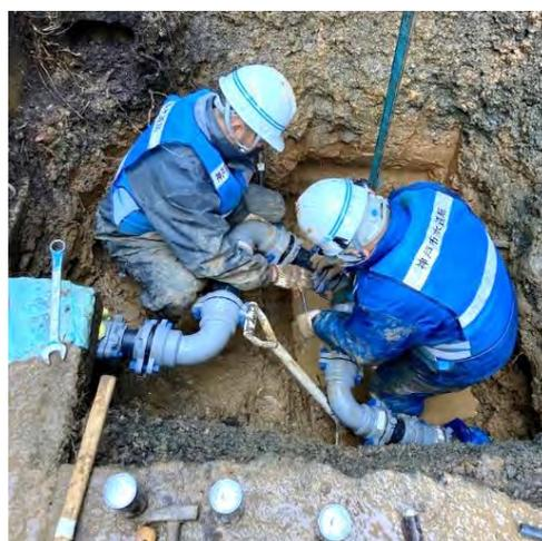
写真6 漏水箇所の修理（穴水町内）
