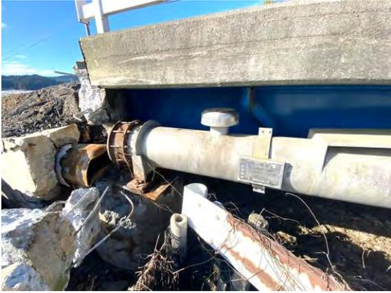
写真3 水管橋の破損 (珠洲市内)
