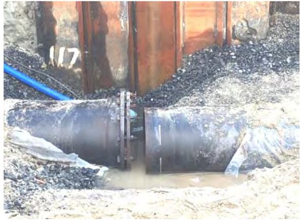
写真4 送水管の破損 (七尾市内)
