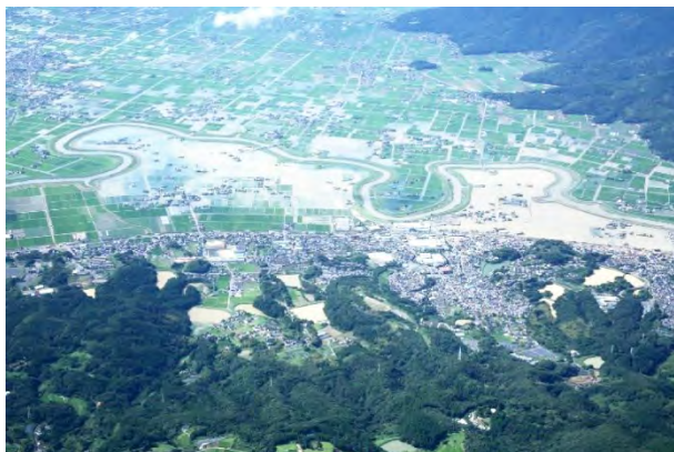
写真 1 大町町浸水の全景
