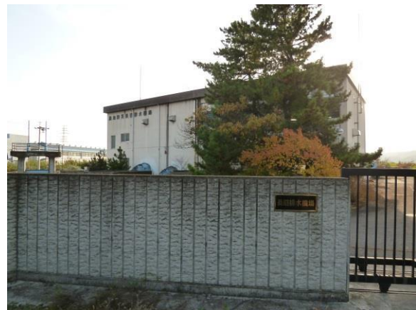
写真4 長沼排水機場
