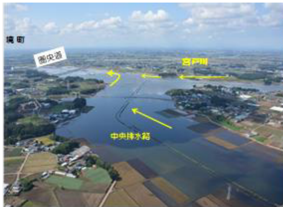
図4-1 宮戸川の堤防決壊により冠水した 長井戸土地改良区
