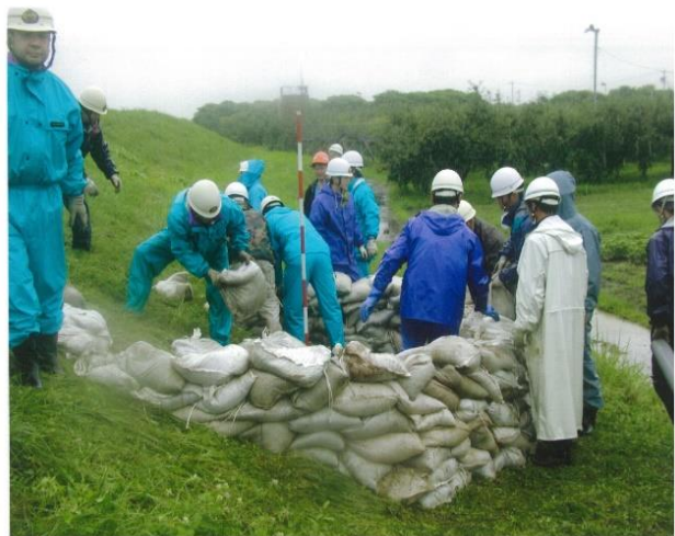
写真2 平成18年7月19日 千曲川堤防水防作業
