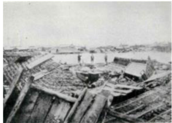
図3-2 明治43年大洪水被害の状況
