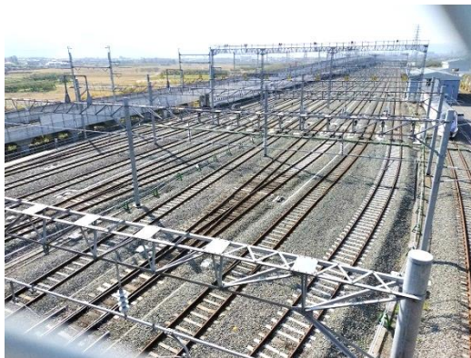
写真8 台風19号で千曲川が氾濫（はんらん）した影響で水没した新幹線基地
