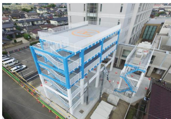
図6：水害避難タワー（左） 非常用発電機タワー（右）
