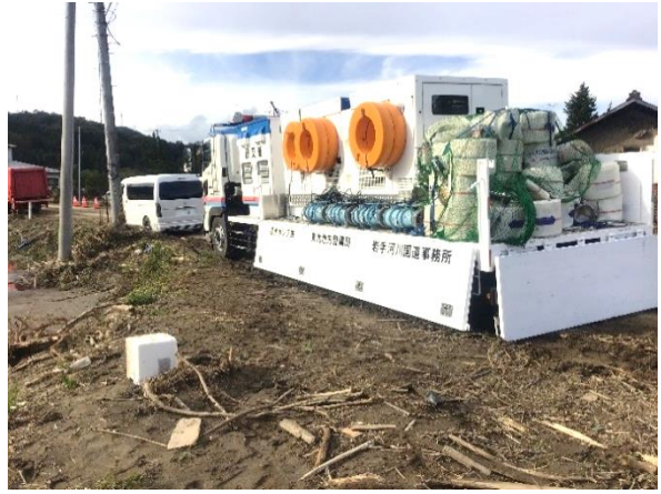
写真4 国土交通省の排水ポンプによる排水活動
