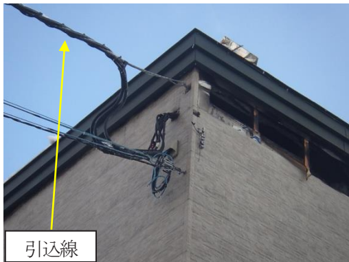
写真3 建物外観北西角の状況
