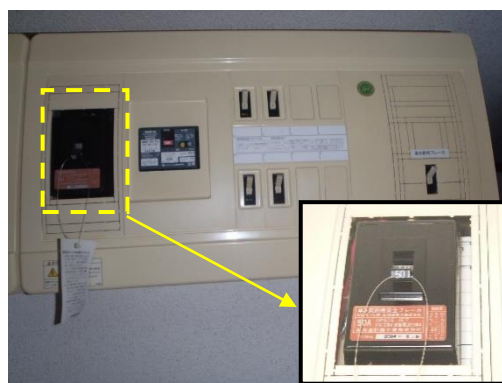
写真13 2階西側にある住戸の分電盤の状況
