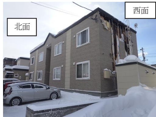
写真1 建物外観の状況
