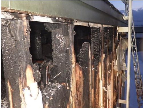
写真2 建物外観西面の状況
