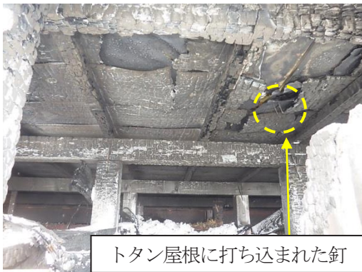
写真8 屋外西面中央から見た小屋裏内の状況
