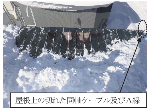
写真5 トタン屋根西端中央の状況
