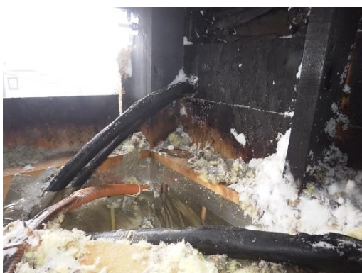
写真11 小屋裏内の引込線貫通部の状況
