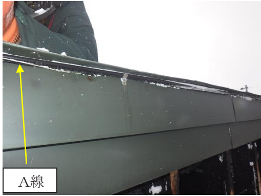
写真7 トタン屋根に沿って固定されている同軸ケーブル及びA線の状況
