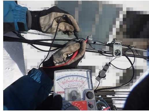
写真20 A線とB線の導通試験の状況
