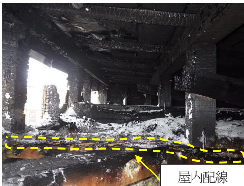
写真9 南側から見た小屋裏内西側の状況
