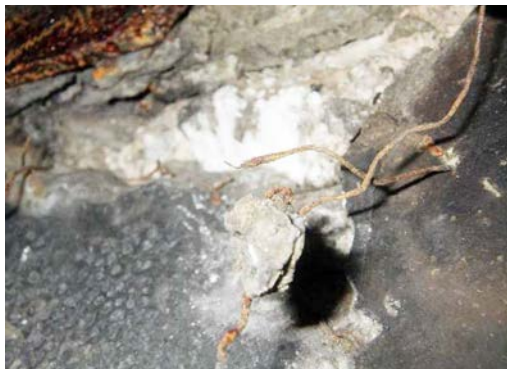
写真14 ワイヤーラスの状況
