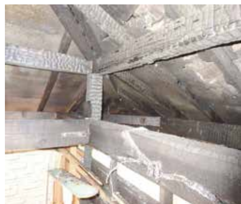
【写真4】2階天井裏
