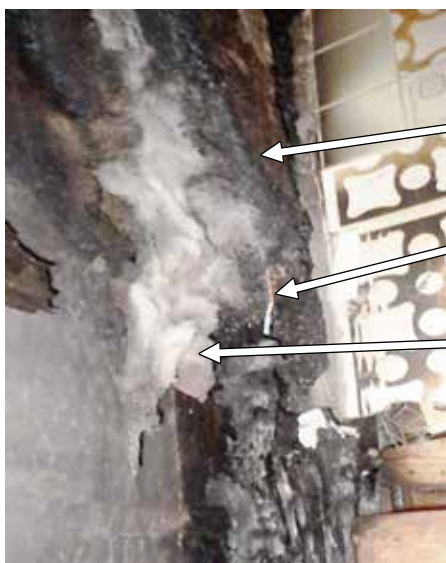
【写真7】1階トイレ壁内
