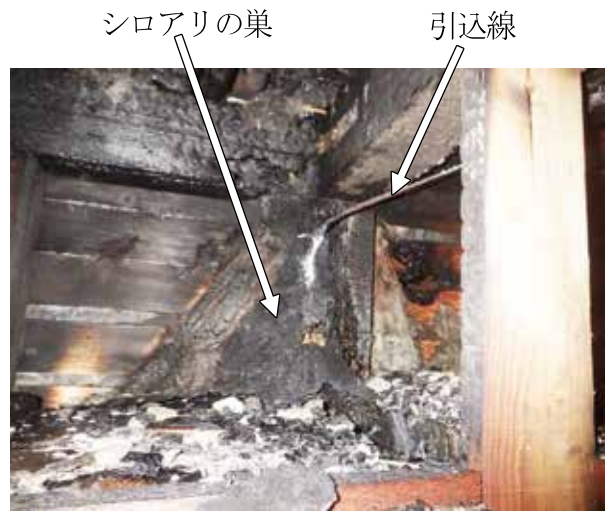
【写真6】1階天井裏
