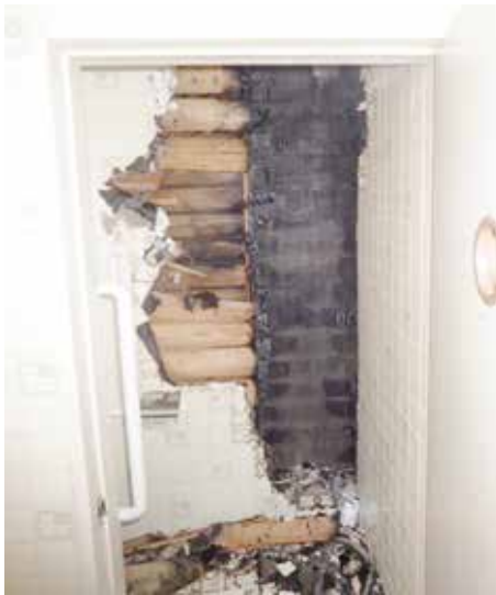
【写真5】1階トイレ
