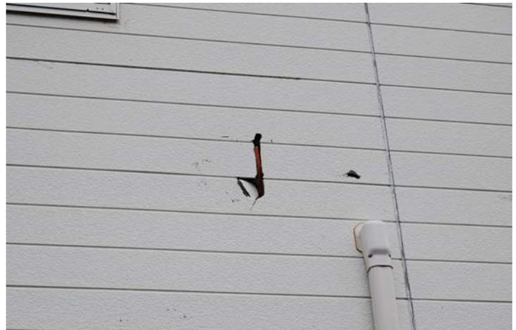
飛来物による被害。屋根瓦と思われるものが、建物側壁に刺さっている。
