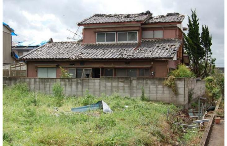
屋根瓦が剥がれ、窓ガラスが割れている家屋。手前には飛来物と思われるトタンが転がっている。
