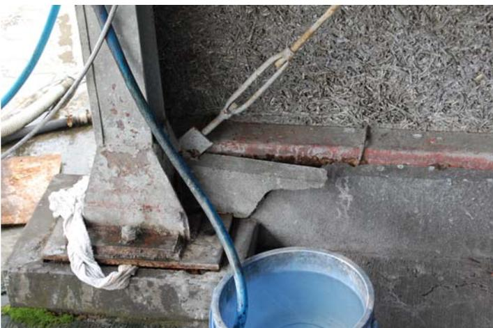
ガレージは、窓ガラス1枚が割れ、屋根が一部破損し、写真の様に基礎と鉄骨の結合部分が浮いてしまった。
