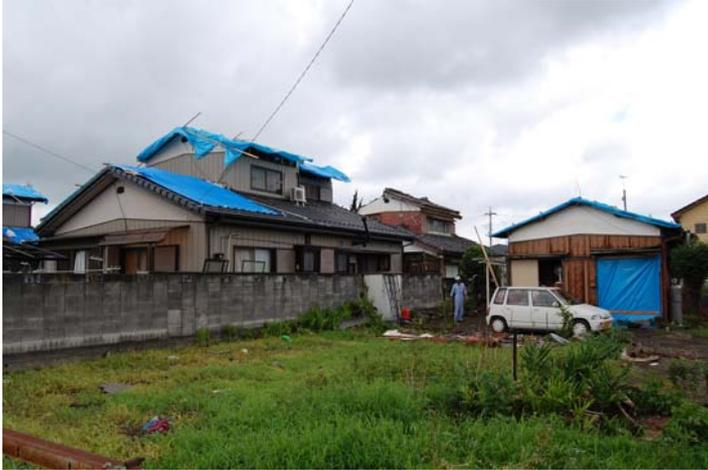
家屋への被害は、主に風で屋根などが巻き上げられる、飛来物が衝突・落下するなどして発生している。
