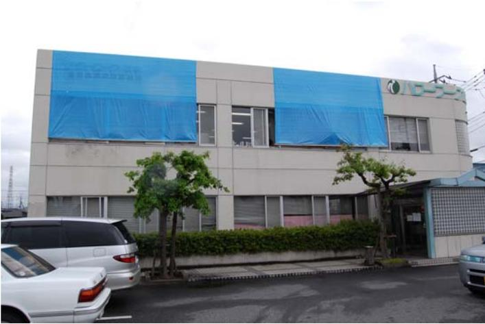
竜巻により2階窓ガラスが割れたハローワーク館林。ブルーシートにより応急処置がされていた。
