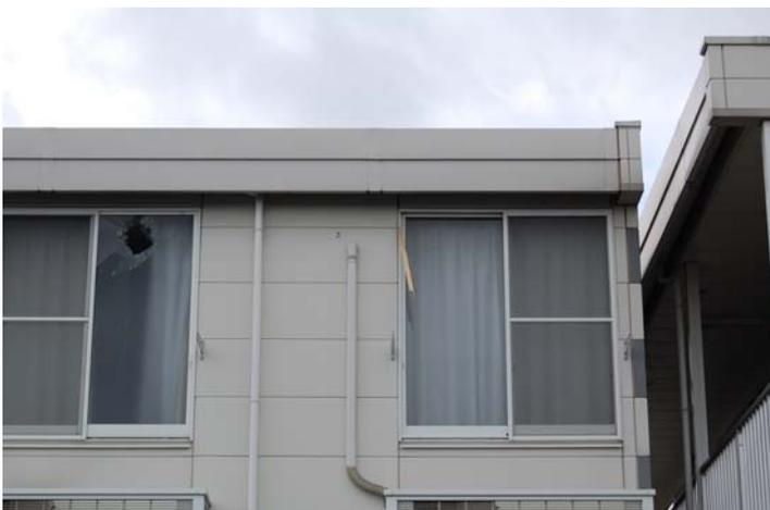
飛来物による被害。左の窓ガラスは穴が空いており、右の窓枠には木材が刺さっている。
