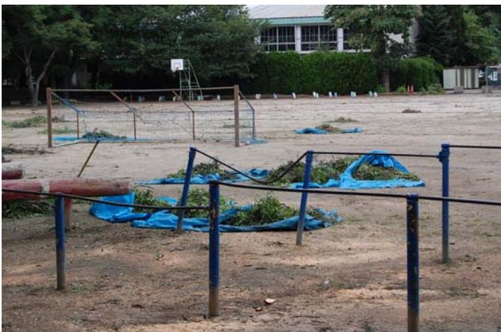
倒れた樹木により曲がってしまった鉄棒。他に雲底も同様の被害を受けていた。
