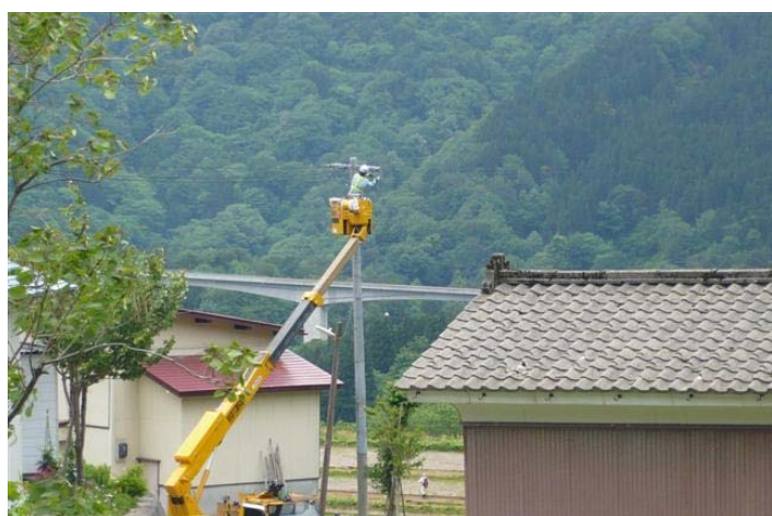
電気工事作業
