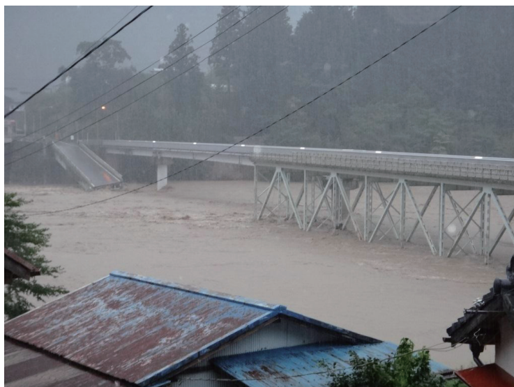
⑤折立橋落橋（十津川村）
