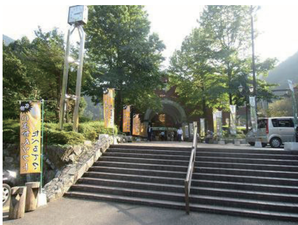
写真4 本館入口付近
