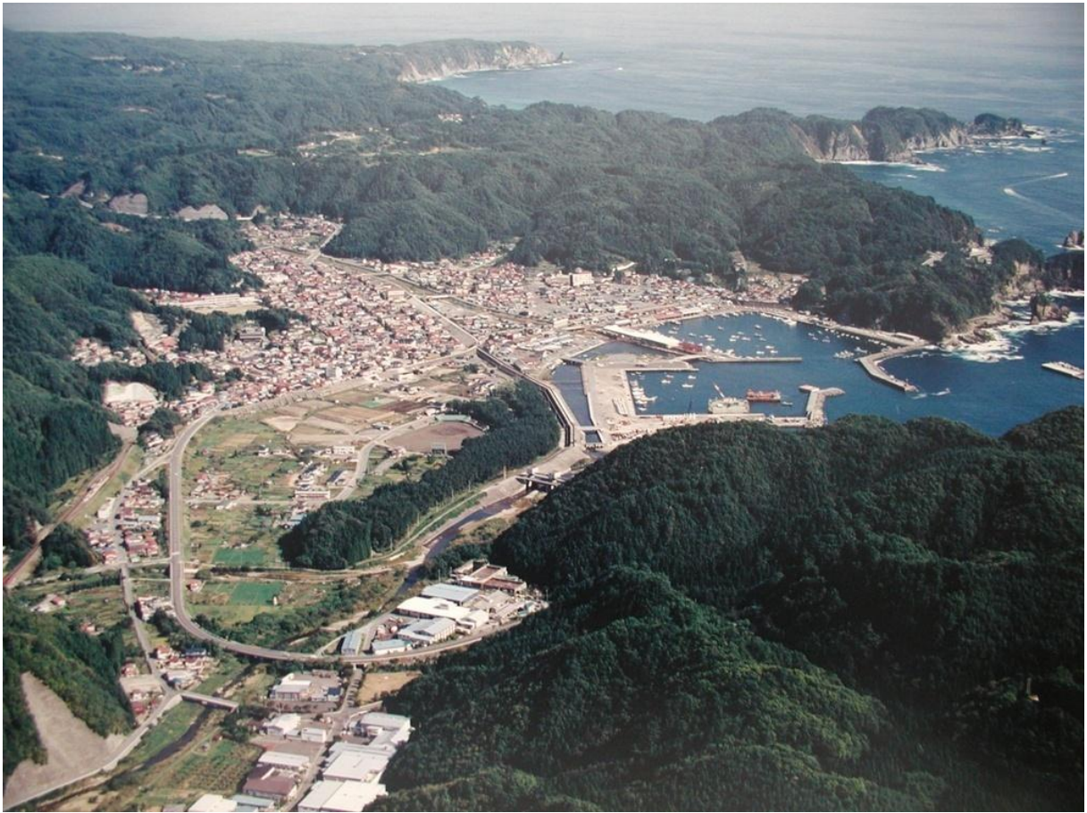
写真 2-8 田老地区の全景（震災前）
