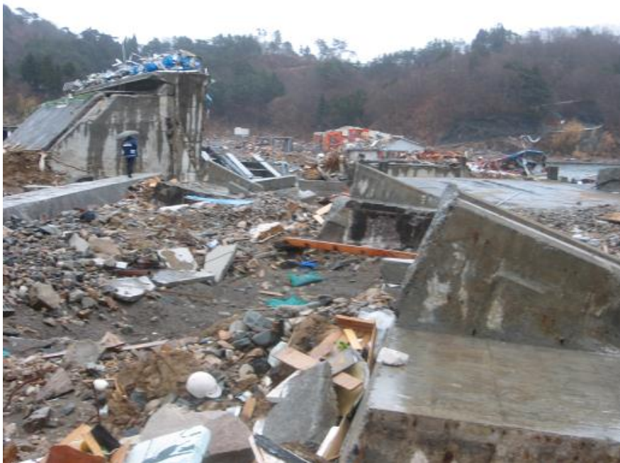
写真 2-1 田老地区防潮堤の被害（震災から約 1 ヶ月後）
