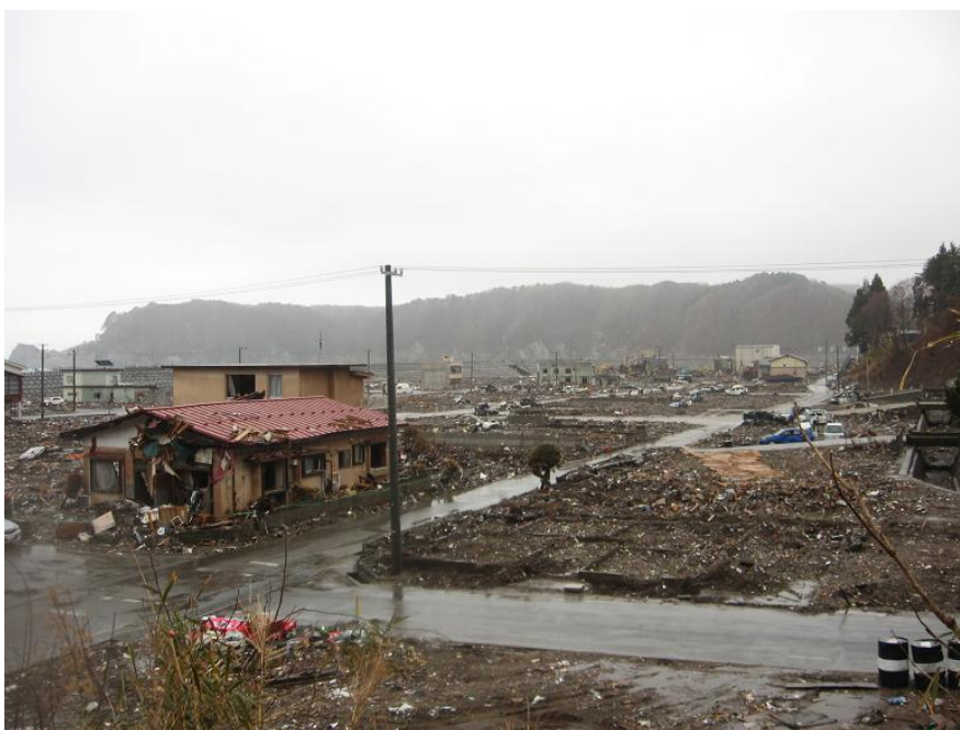
写真 2-2 田老地区市街地の被害（震災から約 1 ヶ月後）
