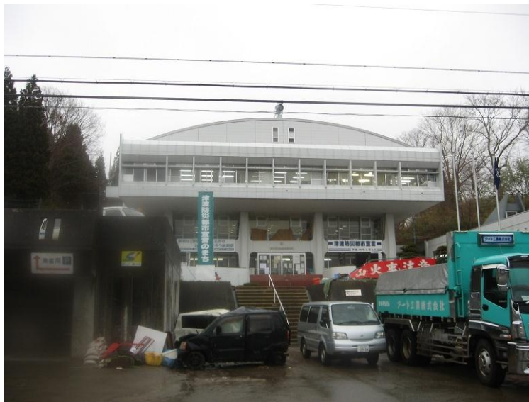
写真 2-3 田老総合事務所（震災から約1ヶ月後）
