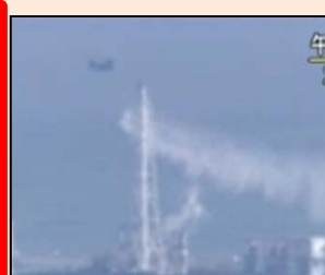
原発への空中放水
