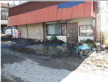
建物への被害 (千葉県我孫子市)
