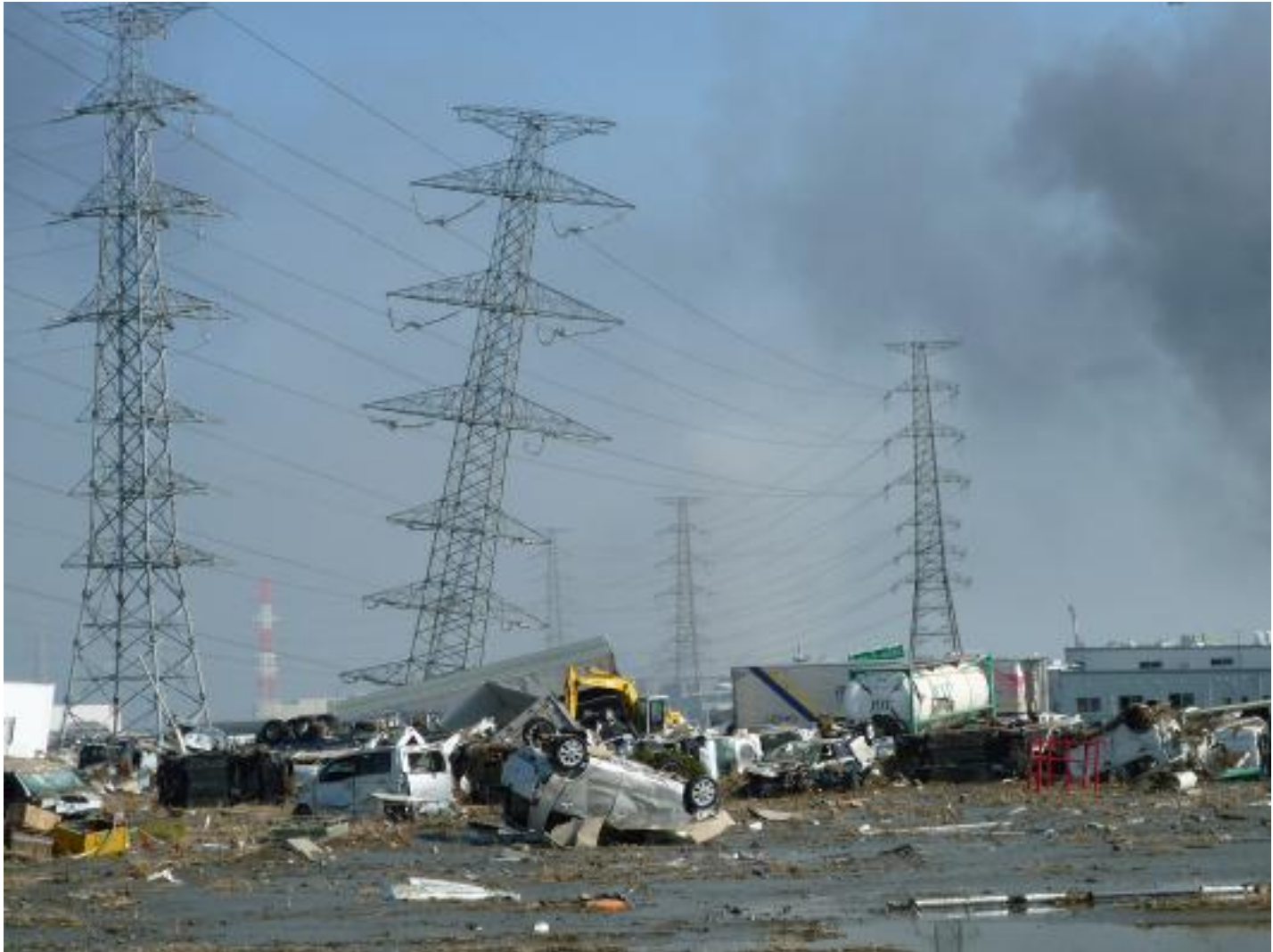
鉄塔倒壊（宮城県多賀城市）
