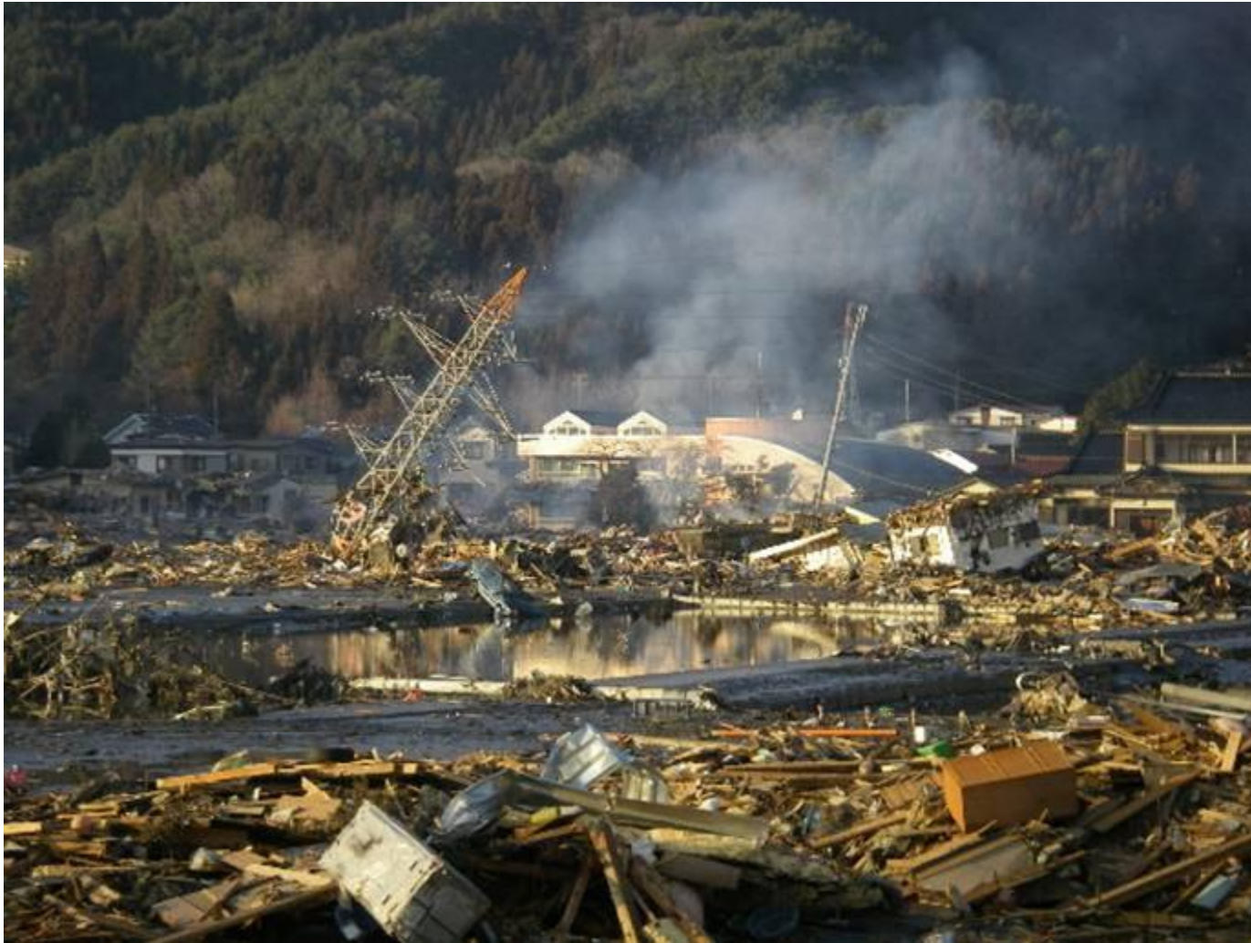
鉄塔倒壊（岩手県大槌町）
