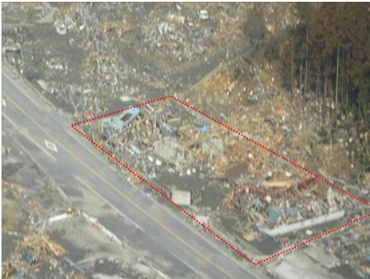
変電所被害状況 (宮城県南三陸町)
