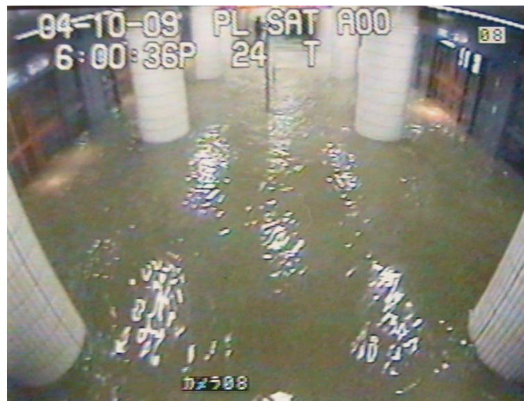
東京メトロ麻布十番駅地下3階の浸水状況 (平成16年台風22号:港区)
