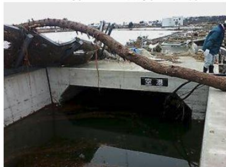
名取方面から空港トンネル入口
