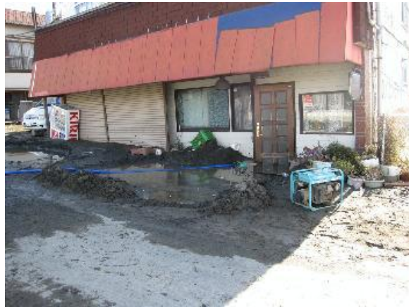
建物への被害(千葉県我孫子市)
