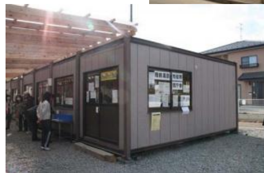
仮庁舎(学校給食センター付近のプレハブ)
