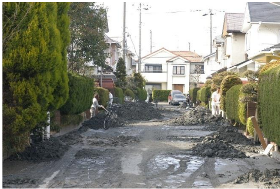
液状化による噴砂(千葉県浦安市)
