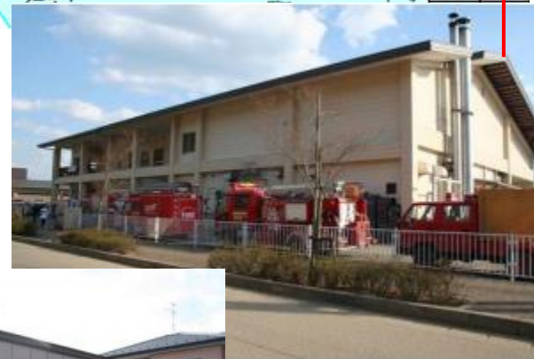
災害対策本部設置場所 (学校給食センター)
