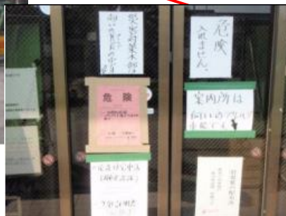
応急危険度判定による「危険」判定
