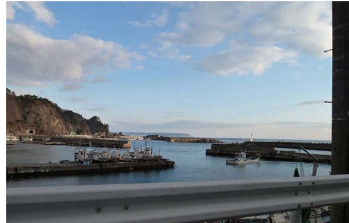
多重防波堤によって背後の浸水高軽減
