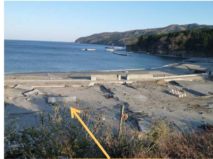
陸側への倒壊
