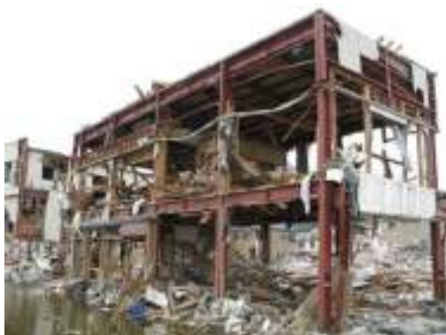
写真 6. 3. 1-11 残存する S 造建築物
