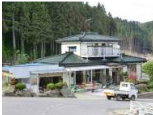
写真 13.17 廻館地区の傾斜地に建つ木造住宅 (1階天井まで浸水)
