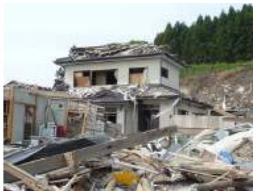
写真 11.2 完全に水没しながらも、流失を免れた木造住宅
