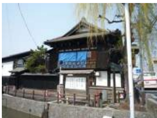
写真 5.4.2-37 母屋3の南側外観
