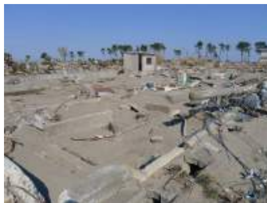
写真 6. 4. 1-16 上部構造が流失し土台が残った例 写真 6. 4. 1-17 上部構造と土台も流失した例
