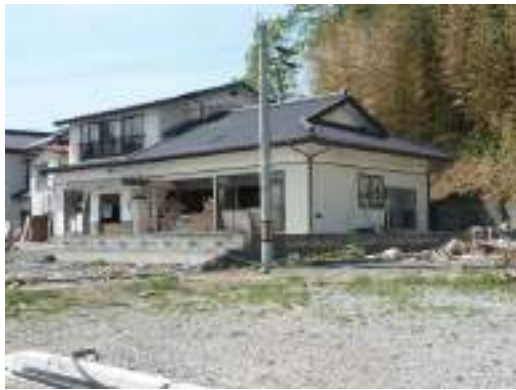
写真 10.5 赤碕町海岸付近で流失を免れた 木造家屋 (浸水深 7 m 以上)
