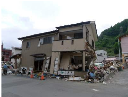
写真 4.4 大きく傾斜した木造
