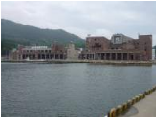
写真 6. 2. 4-1 建築物全景（東側）
