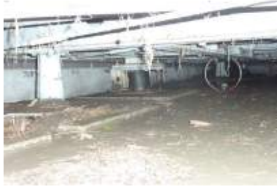
写真 5. 5. 1-38 冠水後の免震層内（左からすべり支承、積層ゴム及び暴風時変位拘束用のワイヤロープ。設計・施工会社からの提供）
