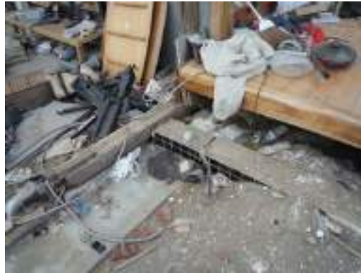
写真 12.14 増築部分の土台
