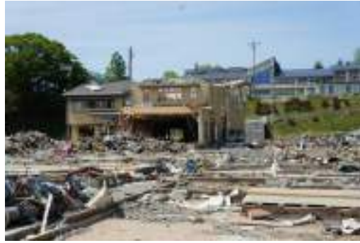
写真 13.8 清水浜駅周辺の流失木造住宅
