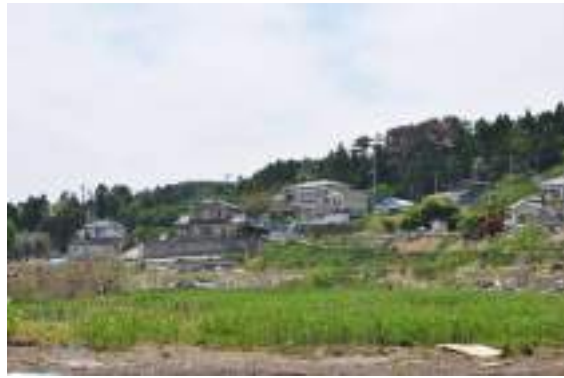
写真 13. 6 歌津馬場地区の残存木造住宅
