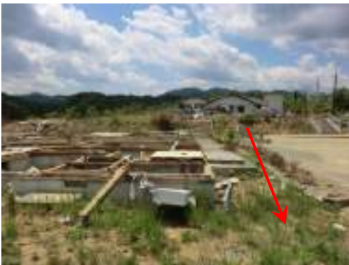
写真 7.8 市営住宅 (注) 手前 (海に近い側) が流失し、奥 (海から遠い側) が残存。
