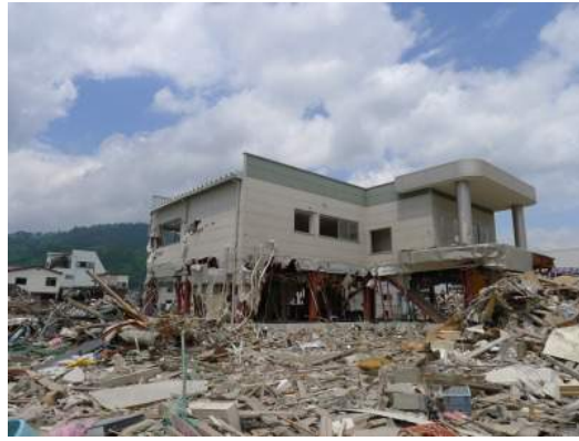
写真 14.2 残存する鉄骨造店舗
