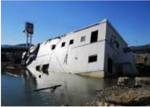
写真6.2.1-11 大きな波圧により流された直接基礎のRC造建築物
