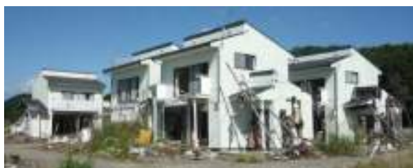
写真2.5 東松島市州崎住宅
