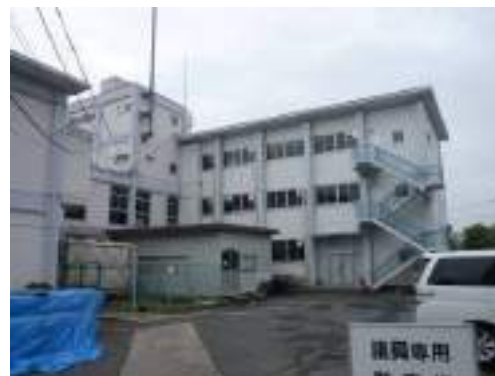
写真B-32 建築物外観 (北面)
