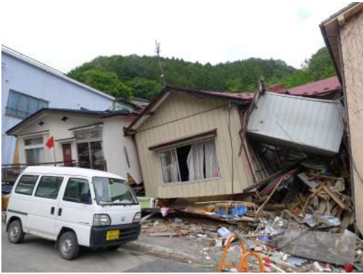
写真 4.1 倒壊した木造
