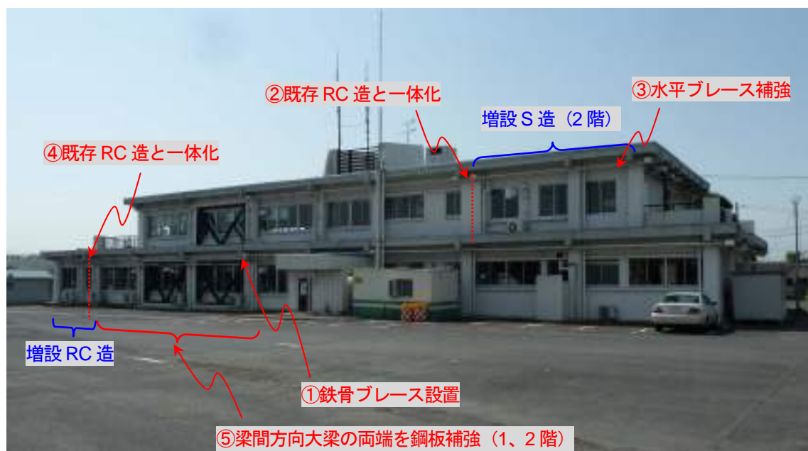
写真 5.2.3.3-1 本建築物外観及び耐震補強概要
