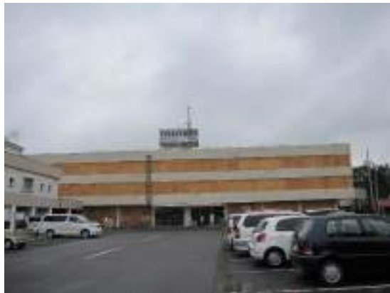
(a) ガラスの落下 (建築物 B)
