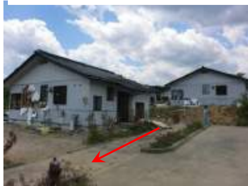
写真 7.9 奥 (海から遠く) にある建物ほど高い場所に建つ。
