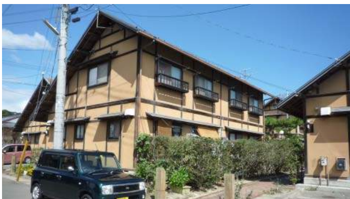
小野駅前第一住宅 (東松島市所管) . . . 浸水深約 42 cm
