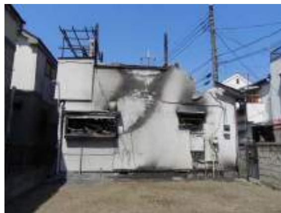
写真 7.2-23 火元建物外観（東側） 手前更地は類焼（全焼）した建物を撤去した跡地
