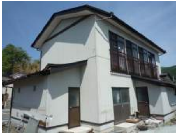
写真6.4.2-4 最大浸水深が7mを超える場所に建ち、ほぼ無被害の木造住宅
