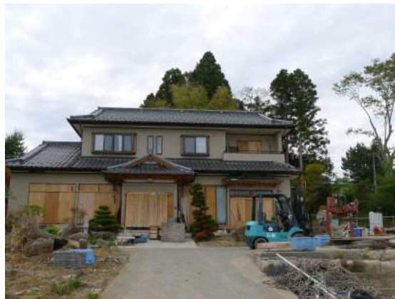
写真 18.2 残存する木造住宅
