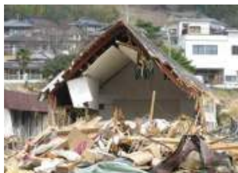
写真 6. 3. 1-10 傾斜した山形ラーメン架構
