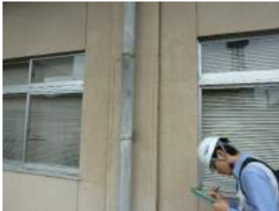
写真 B-19 無損傷の袖壁付き柱 (1階)
