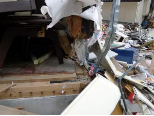
写真 4.9 前写真の柱脚部
