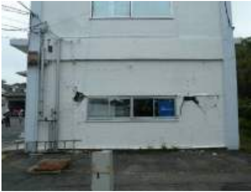
写真 5. 2. 2-10 コンクリートブロック造壁の被害 (建築物 H)
