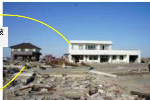
写真 6. 4. 1-4 入射方向に低層 RC 建築物 (浸水深約 6m) があって、残存した木造住宅
