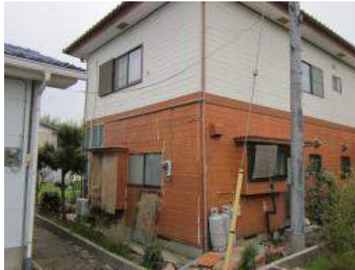
写真 5. 4. 2-20 外観－北東角／外壁補修箇所
