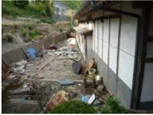
写真 12.9 数メートル移動した写真 5.8 の家屋
