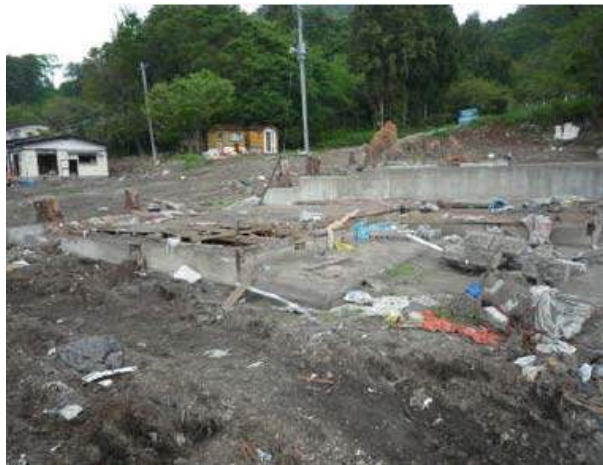
写真 6.4.2-2 写真 6.4.2-1 の住宅地の標高が低い場所における流失家屋の跡
