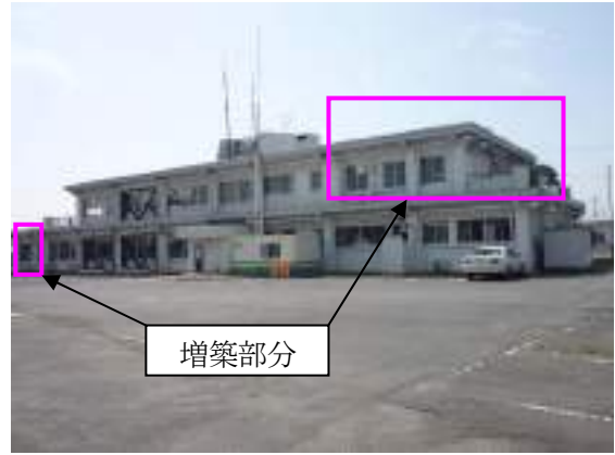
写真 B-48 建築物外観（北側）
