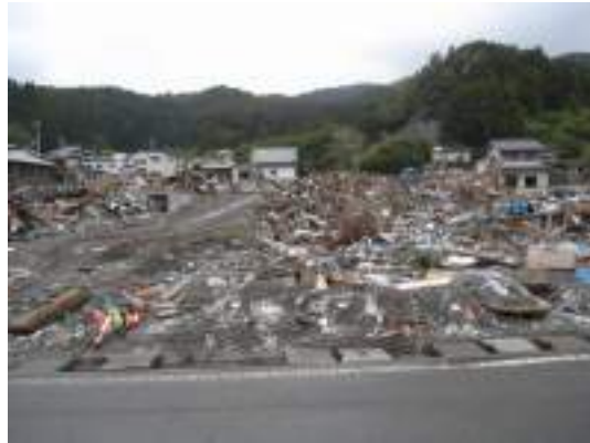
写真3.2 傾斜地手前の流失家屋と奥の非流失家屋
