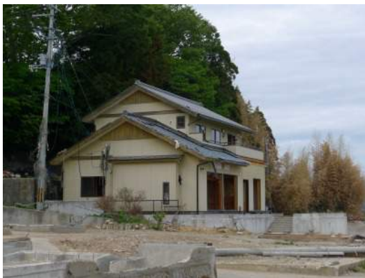
写真 18.3 残存する木造住宅
