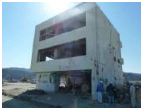
写真 6.2.1-3 残存する3階建て建築物
