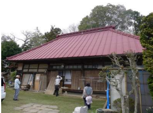
写真 5. 4. 2-15 調査建物の外観
