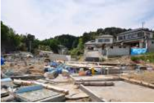
写真 13.7 歌津館浜地区の流失・残存木造住宅
