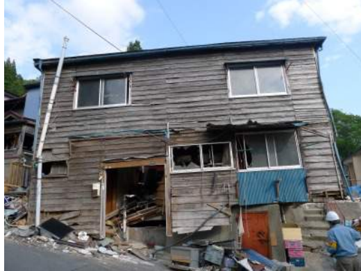
写真 4.12 基礎上端で大きく移動した木造
