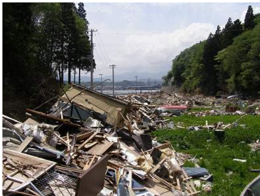
写真 15.1 小々汐の入り江内陸部の津波被害
