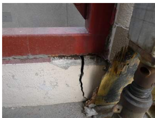
写真 5. 4. 2-26 基礎の亀裂
