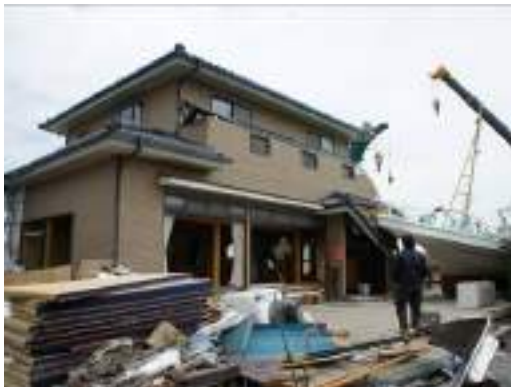
写真 6. 4. 1-6 津波の作用方向に開口が多く残存したと考えられる事例
