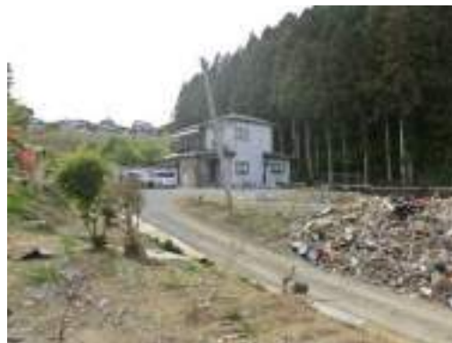
写真 13.19 館地区の傾斜地に建つ木造住宅のうちの1棟 (1階下部まで浸水)
