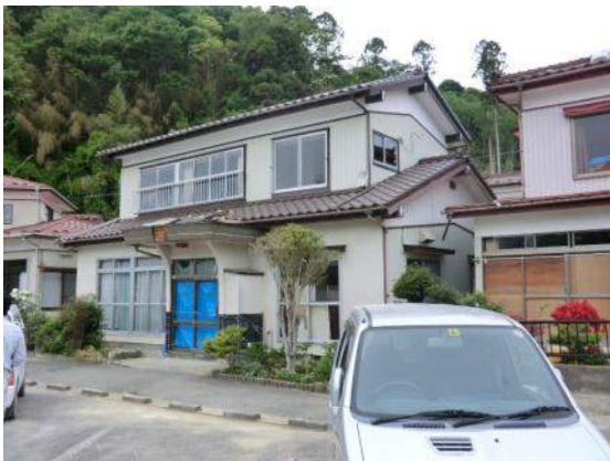
写真 13.23 宮ヶ崎宮ヶ崎の浸水被害
