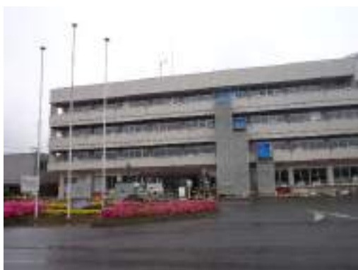
写真B-13 建築物外観
