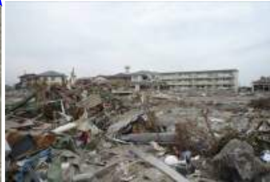
写真 6. 4. 1-4 津波の入射方向に建つ建築物により津波波力が軽減し、残存したと考えられる例 (名取市閑上地区)
