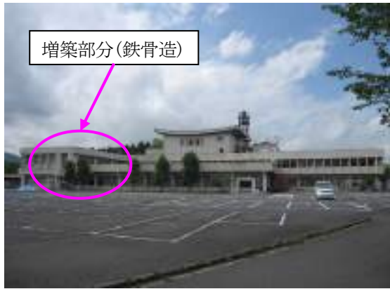
写真 B-41 建築物外観（南側）
