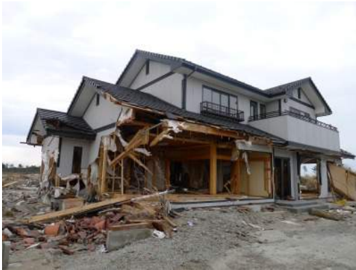
写真6.4.1-8 建築物隅部を流失しつつも残存した事例(1)
