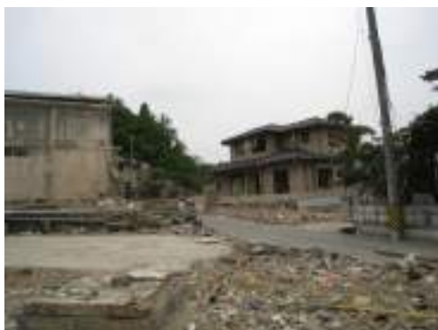
写真 13.24 桜ヶ丘の流失跡と残存住宅
