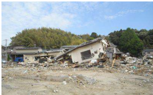
写真 19.3 壊滅的な被害を受ける室戸地区
