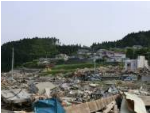
写真 13.16 廻館地区の傾斜地に建つ木造住宅
