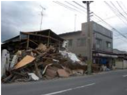
写真 5. 4. 2-45 増築部分が倒壊した隣家
