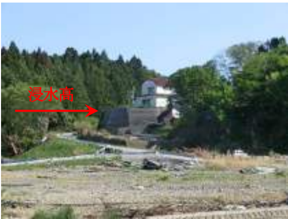
写真 7.24 高台に建つ木造住宅
