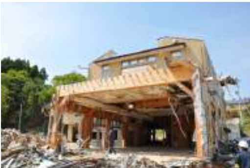
写真 13.9 残存する集成材フレーム構造
