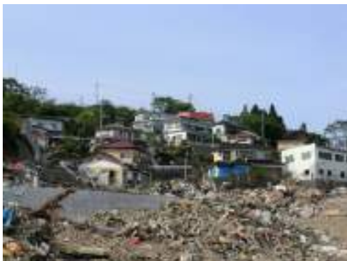
写真 13.12 上ノ山地区の傾斜地に建つ木造住宅
