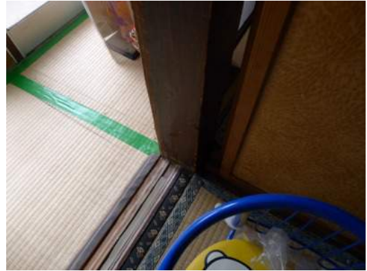
写真 5. 4. 2-6 水平方向に移動した柱脚
