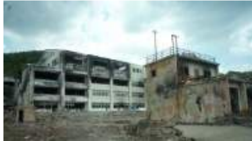
写真 2.2 火災が発生した大槌町中心部
