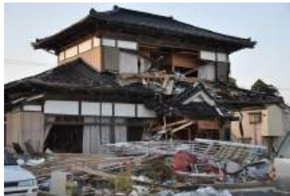
写真 7. 30 漂流物により損傷したと考えられる 木造住宅 (本吉町野々下地区)
