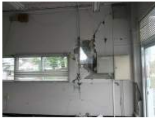
写真 5. 2. 2-10 コンクリートブロック造壁の被害 (建築物 H)
