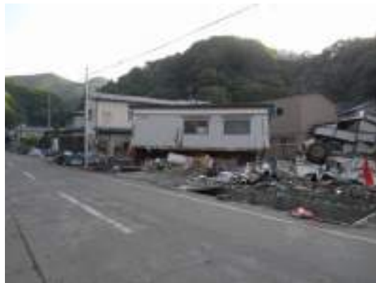
写真 5.2 流失境界付近の被害状況
