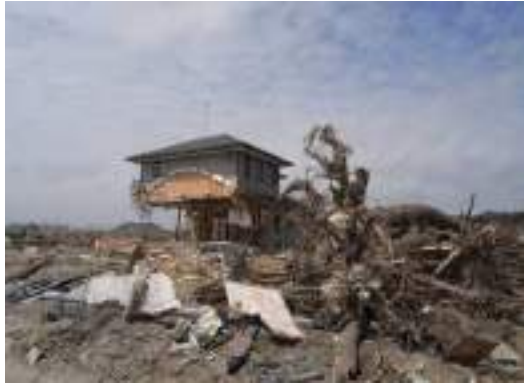
写真 19.1 本土側、東名地区の被害
