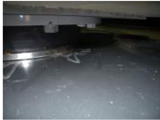
写真 5. 5. 1-23 すべり面に生じたきず
