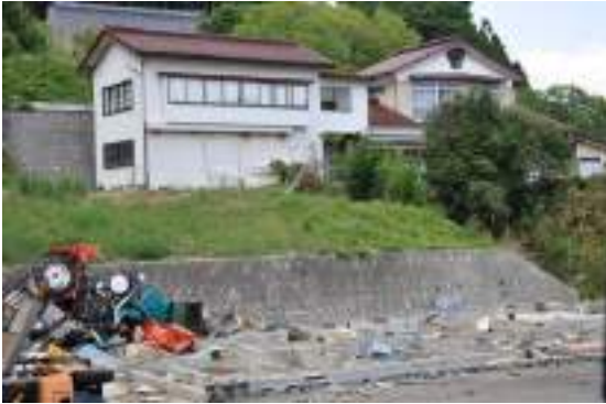
写真 7.10 残存する木造住宅 (本吉町二十一浜)
