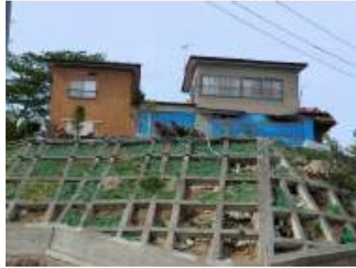
写真 13.15 城場地区の傾斜地に建つ木造住宅 (1階天井まで浸水)
