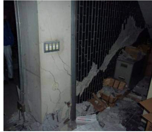
(b) 1階耐力壁のせん断破壊
