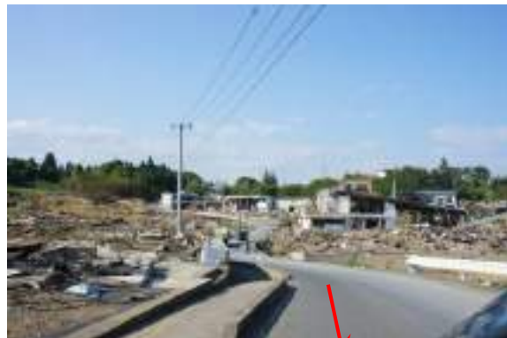
写真 7.26 写真 7.25 の漁業協同組合 (手前) と JA 南三陸大谷支店 (奥 : S 造)。JA 南三陸大谷支店は津波により大きな被害を受けていた。
