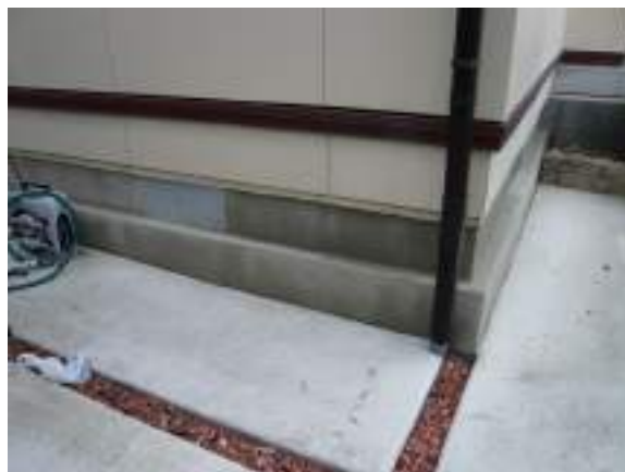
写真 5.5.1-35 基礎立上り部のブロック : 修理済み
