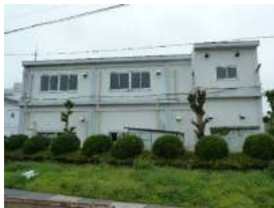
写真 B-38 建築物外観（北面）
