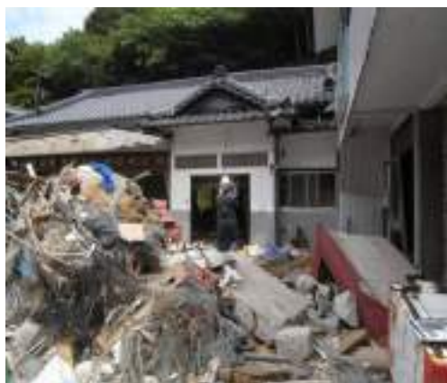
写真 20.10 残存家屋(⑦)と浸水痕の調査
