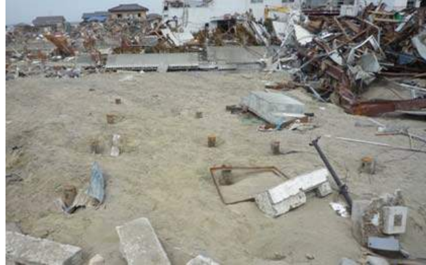
写真 6.4.1-13 べた基礎ごと建設地から移動し残存した例（右は当所位置に残る鋼管杭）
