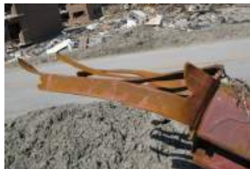
写真6.3.1-4 引き裂かれた梁フランジ
