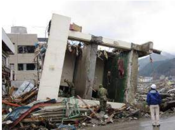
写真 6.2.3-2 建築物 西側立面
