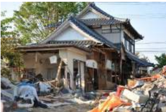
写真 7. 31 道路南側の被害が甚大な住宅
