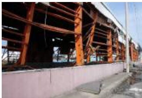
写真 6.3.1-13 柱の変形
