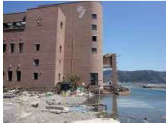
写真 6. 2. 4-2 建築物周囲の地盤沈降
