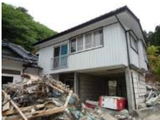
写真 20.11 1階を組積造として3.0mの 浸水深に耐えた家屋
