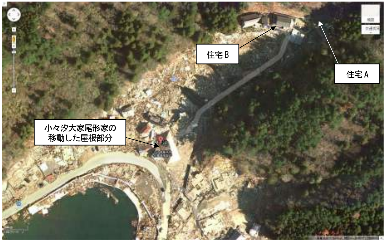
図 15.2 気仙沼市小々汐周辺の津波被害状況
