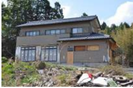
写真 7.17 残存する木造住宅 (本吉町幸土地区)
