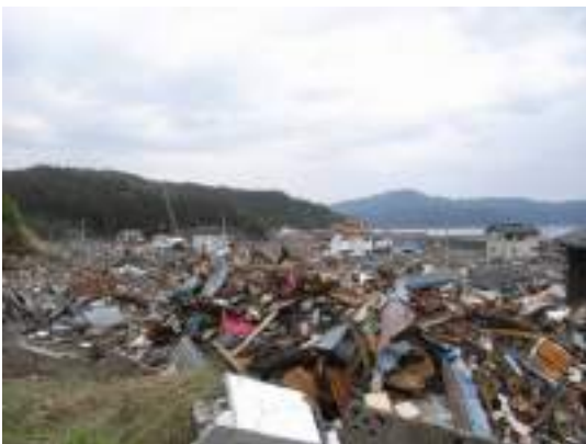
写真3.3 流失境界より下側の住家の流失 （例外的に残留した数棟の住家）
