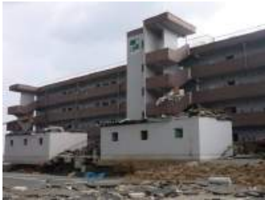
写真 6.2.2-3 外部階段と津波避難ビルを示す看板
