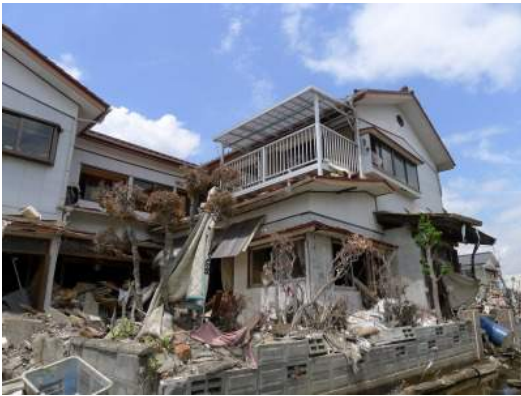
写真 14.3 残存する木造住宅
