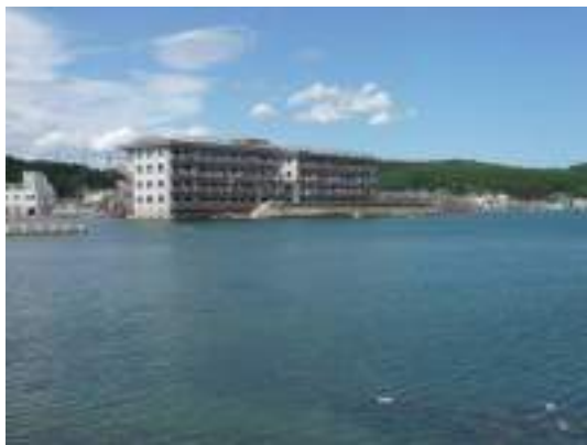
写真 6.2.2-1 被災後の建物状況 (南側)
