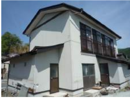
写真 10.3 赤碕町海岸付近で無被害の木造 (浸水深 7 m 以上)
