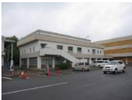
写真 B-10 建築物外観
