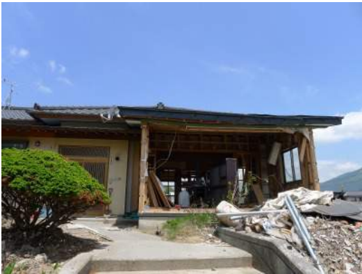
写真 8.5 前写真の建物の開口
