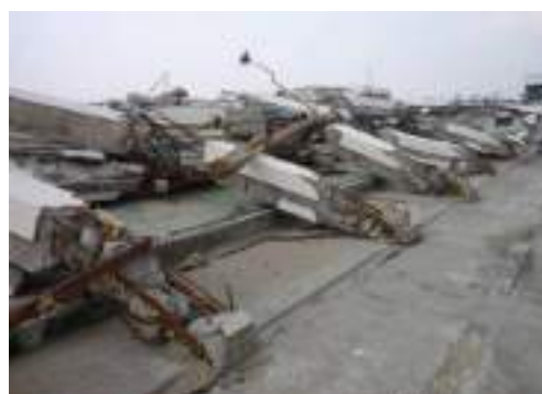
写真 6.2.1-1 2階建て建築物の倒壊
