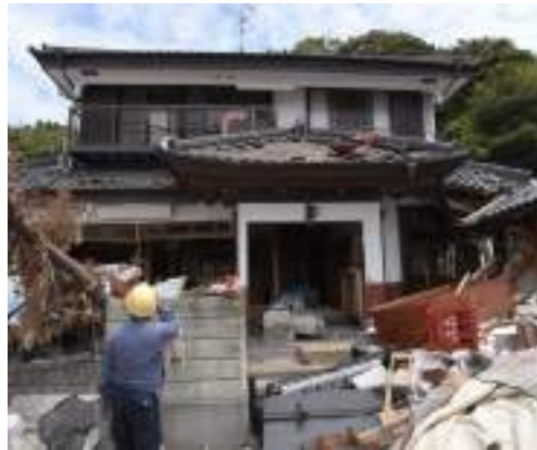
写真 20.4 写真 20.3 に隣接して残存する家屋 (②)
