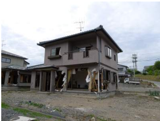
写真 17.5 残存する木造住宅
