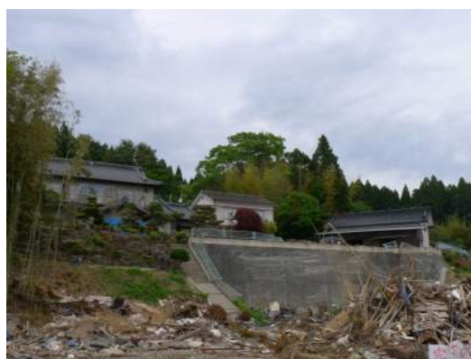
写真 16.2 擁壁の上の木造住宅
