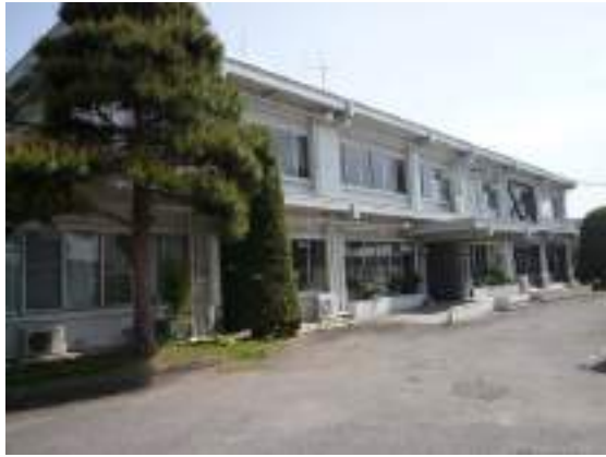
写真 B-47 建築物外観（南側）
