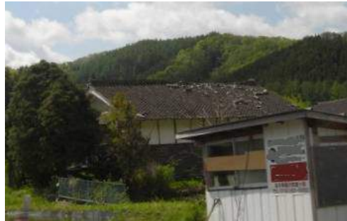
写真 1.2 棟瓦の被害
