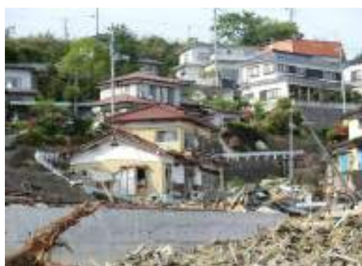
写真 13.13 中央の木造住宅は2階開口部上部まで浸水
