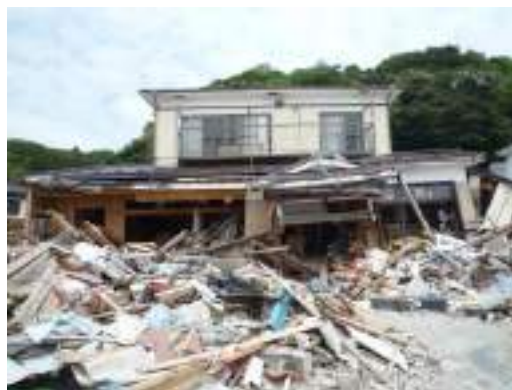
写真 20.6 残存するも大きく損傷した家屋(③)
