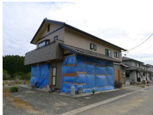
写真 17.4 残存する木造住宅
