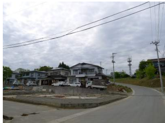
写真 17.6 残存する木造住宅
