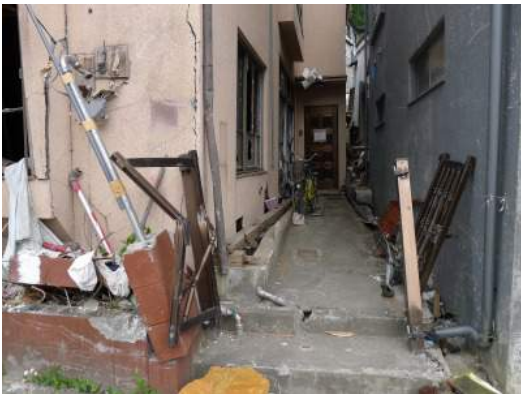
写真 4.3 前写真の建物のずれ
