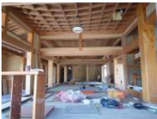
写真 10.7 写真 3.6 の内部 (浸水深 6~7 m)
