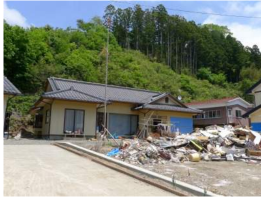
写真 14.6 残存する木造住宅
