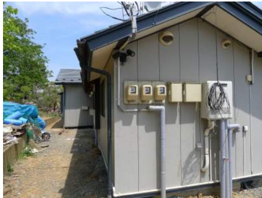
写真 8.6 残存した木造住宅
