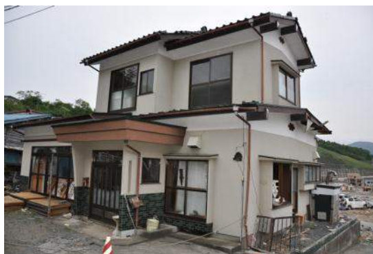
写真 13.27 桜ヶ丘の浸水した住宅
