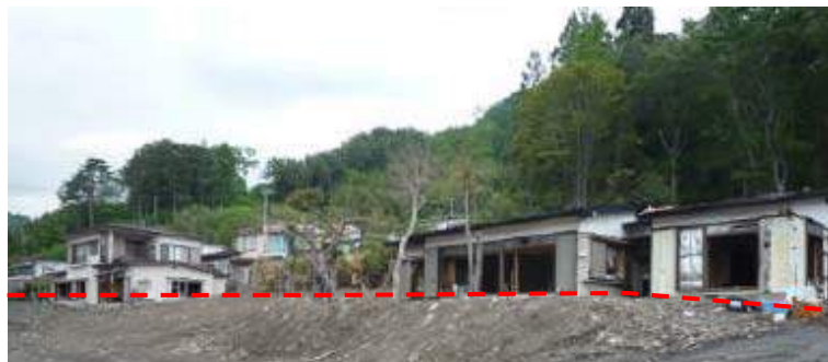
写真 6.4.2-3 写真 6.4.2-1 の住宅地の標高が写真 6.4.2-2 よりも高い場所に建つ建物。 (赤破線よりも標高が低い場所に建つ建物はほぼ流出)
