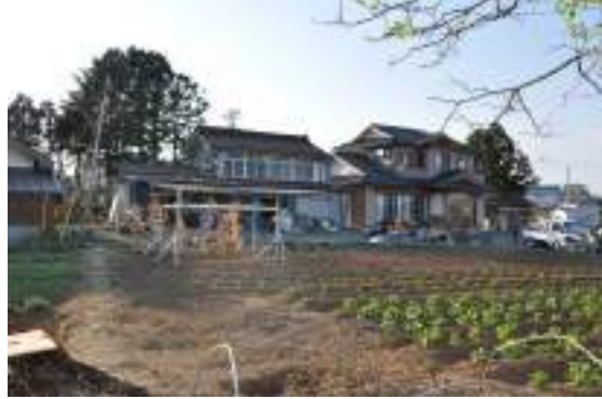
写真 7.33 写真 32 に隣接する被害軽微な 木造住宅
