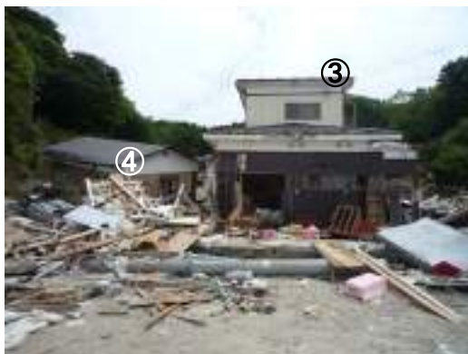
写真 20.5 流失した木造家屋 (④) と残存する木造家屋 (③)
