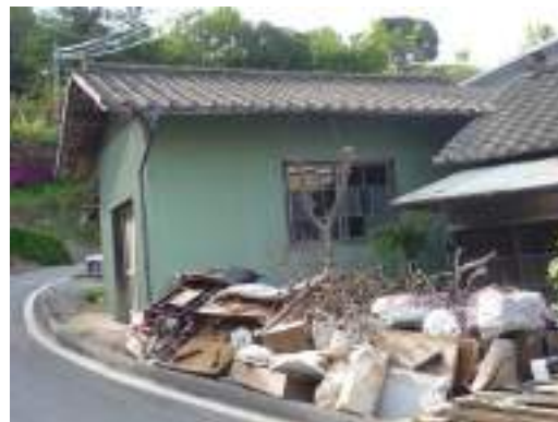
写真 12.2 浸水深 1.7m の倉庫
