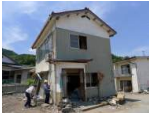
写真 9.2 浸水深測定建物
