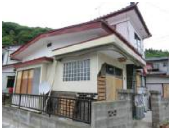
写真 13.22 宮ヶ崎宮ヶ崎の津波による被害
