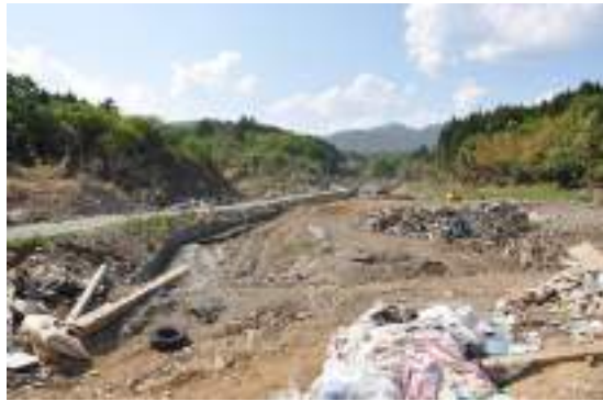
写真 7.19 流失した木造住宅(本吉町赤牛地区)
