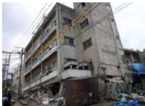
写真 5.2.1-1 1階の層崩壊
