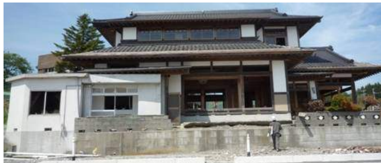
写真6.4.2-5 浸水深6～7mの場所に建ち、流出を免れた木造住宅
