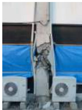
(b) 短柱せん断破壊
