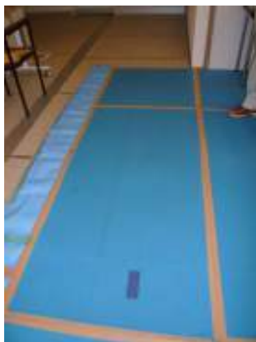
写真 5. 5. 1-49 1階エレベーター周囲の養生 (補修後)
