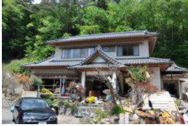
写真 6. 4. 2-7 浸水深 5m の場所に建ち、流出を免れた木造住宅
