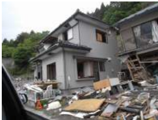
写真3.4 流失境界付近の木造住宅の被害
