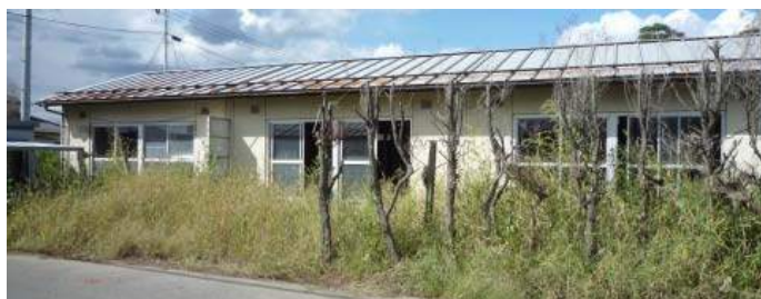
写真 4.1 岩沼市林住宅の外観 (メゾネット)
