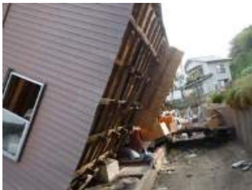
写真 12.7 転倒した家屋の脚部
