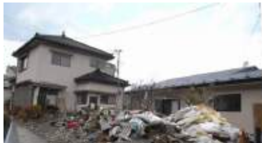
写真 2.8 ポンプ小屋の入射方向と反対方向に残る木造家屋 (③ : 左、④ : 右)
