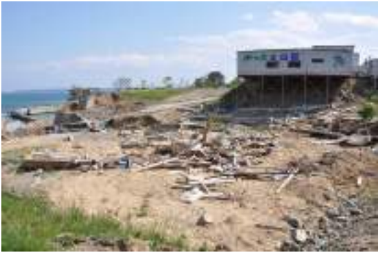
写真 7.16 流失した河口付近の木造住宅 (本吉町幸土地区)
