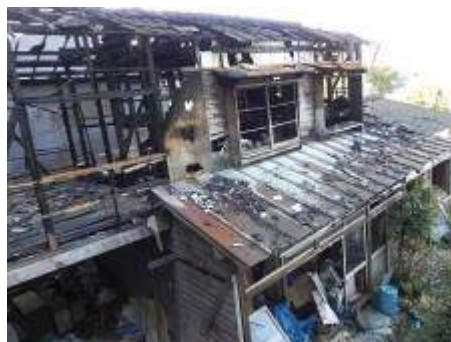
写真 7.2-8 出火した住宅
