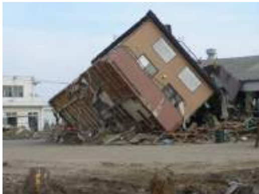
写真 6.4.1-14 転倒した木造建築物
