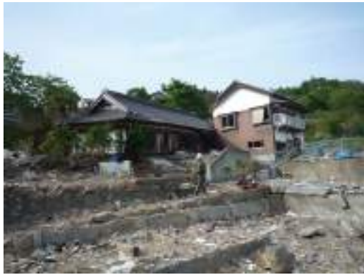
写真 12.11 移動して 2 階建て住宅に衝突
