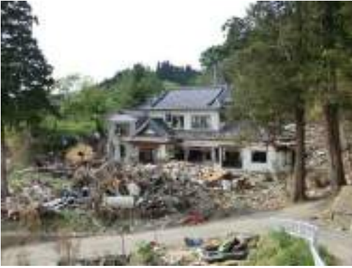
写真 13.14 城場地区の傾斜地に建つ木造住宅 (2階中央の高さまで浸水)
