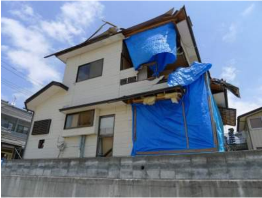
写真 14.5 残存する木造住宅
