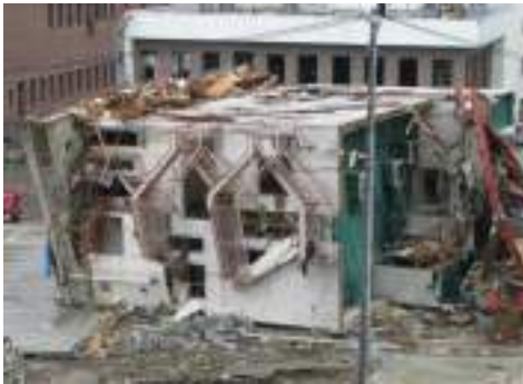
写真 6.3.1-5 3階建てS造の転倒
