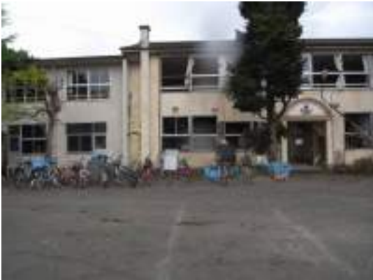
写真3.1 赤浜小学校（右側が損傷した木造）
