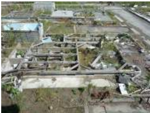
写真 2.6 流失した住戸の基礎と土台
