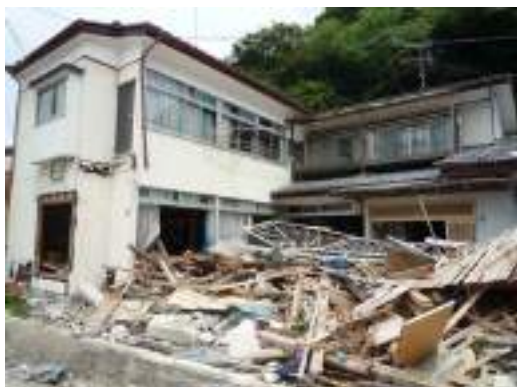
写真 20.9 一部損壊しながらも残存する 木造家屋 (⑥)
