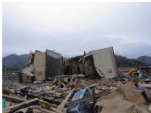
写真 6.2.1-8 CB造集合住宅の転倒
