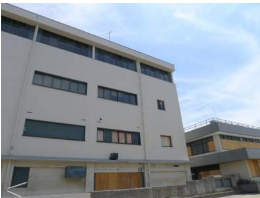
写真 8.1 15.4m の浸水深で残存した鉄筋コンクリート造
