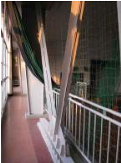
写真 5.3-18 増設した V 型の補強ブレース
