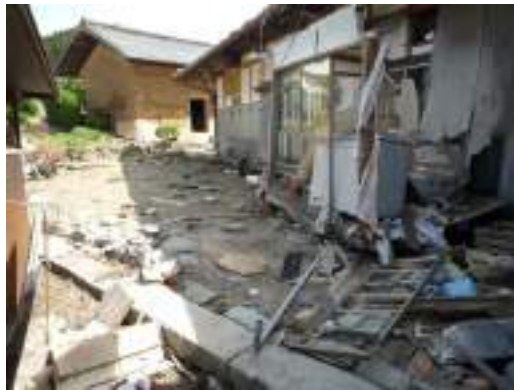
写真 10.18 回転移動した古民家
