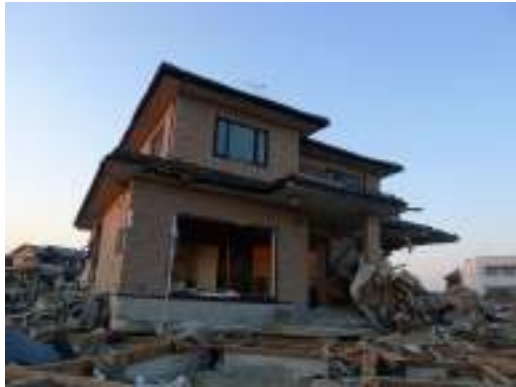
写真 6.4.1-13 べた基礎ごと建設地から移動し残存した例（右は当所位置に残る鋼管杭）
