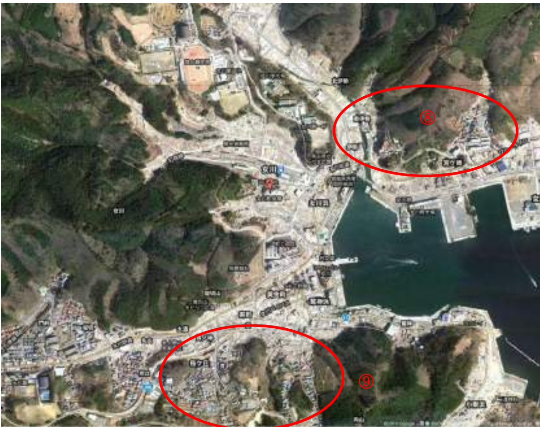
写真 13.4 女川町の被害調査地域（女川駅周辺）
