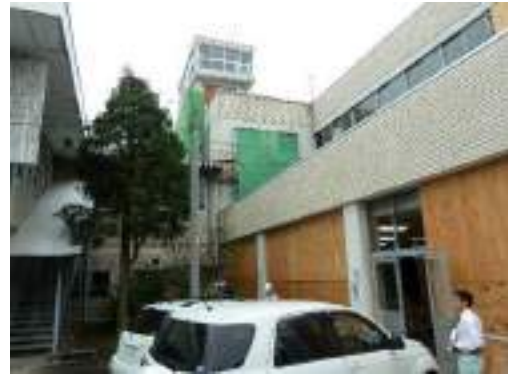
写真 B-9 北側構面のセットバック状況
