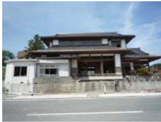
写真 10.6 流失を免れた伝統的構法住宅 した作業小屋
