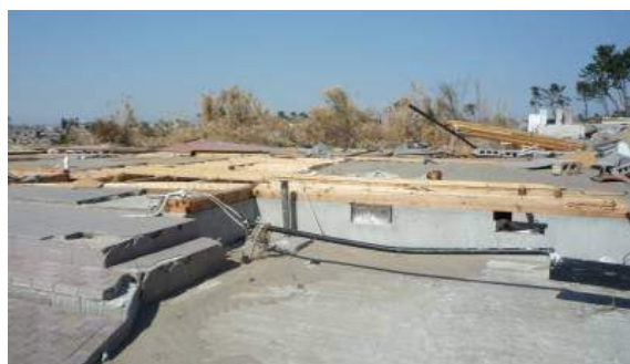
写真 6. 4. 1-16 上部構造が流失し土台が残った例 写真 6. 4. 1-17 上部構造と土台も流失した例
