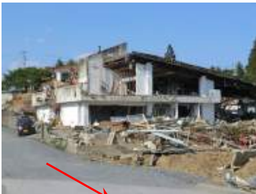
写真 7.25 宮城県漁業協同組合大谷本吉支店 (RC 造)。津波による大きな被害を受けていた。
