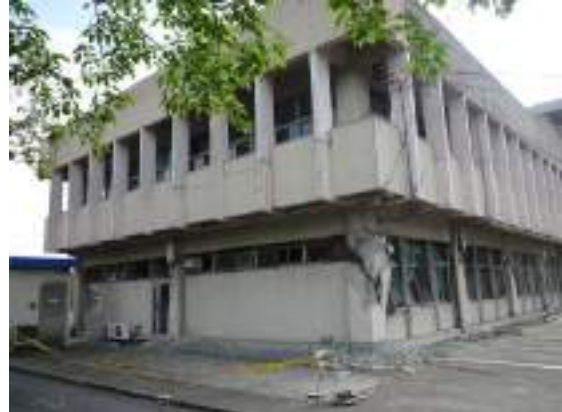
写真 B-42 建築物外観（東側）
