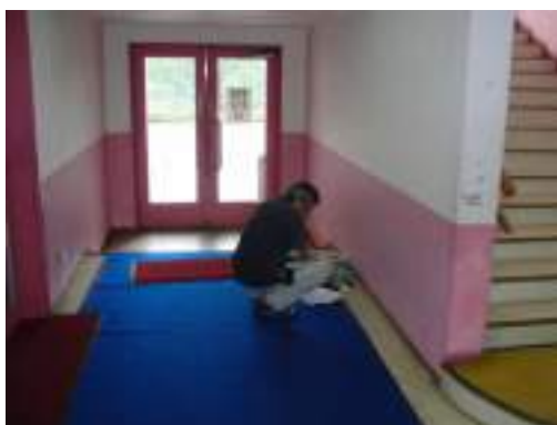
写真 4.3-3 体育館1階床への設置状況
