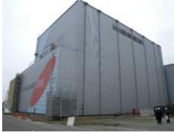
図 5.5.1-7 B建築物（鉄骨造）
