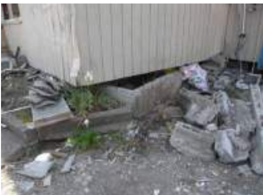
写真 9.3 浸水深測定建物の移動状況
