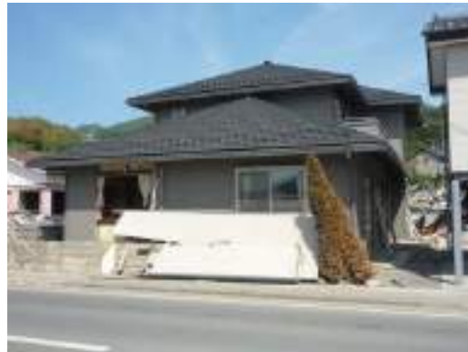
写真 10.13 浸水深 5m に対して残存した軽量鉄骨造住宅（浸水深 5 m）
