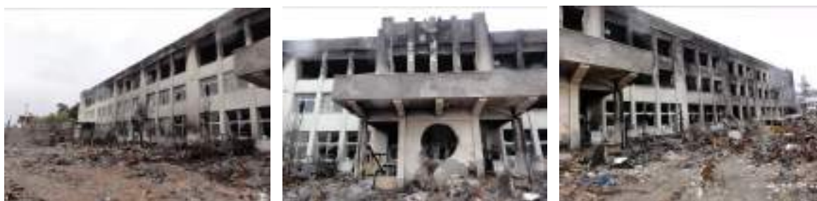
写真 7.3-9 門脇小学校(左から、校舎西側、校舎中央、校舎東側)
