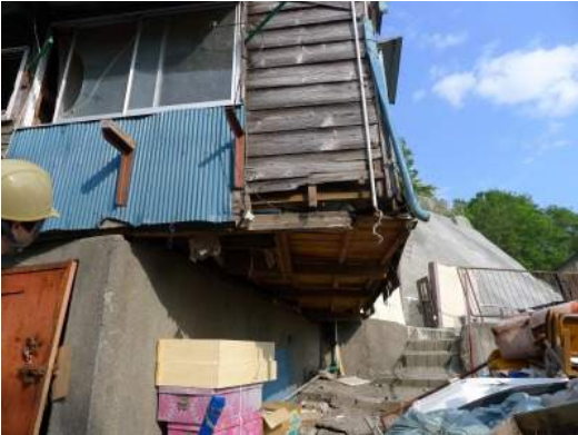
写真 4.13 前写真の建物の基礎上端部
