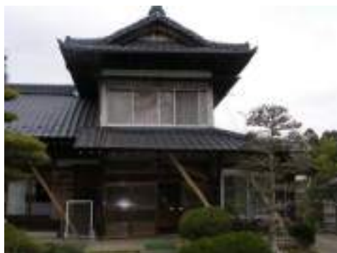
写真 5. 4. 2-1 外観と仮筋かい補強
