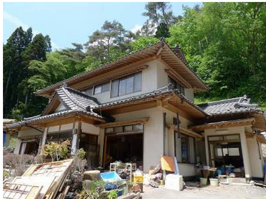
写真 15.3 住宅Bの外観
