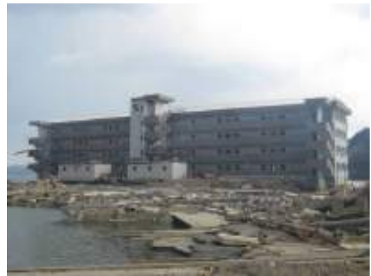
写真 6.2.2-2 被災後の建物状況 (北側)
