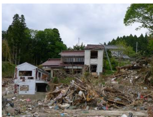
写真 16.3 移動した木造住宅
