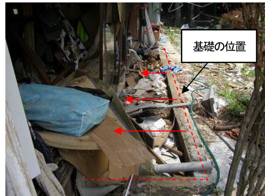
写真 15.4 住宅Aの上部構造の移動
