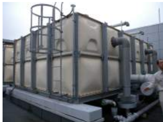
写真 5. 5. 1-28 自家発電機用防振ゴムのはみ出し 写真 5. 5. 1-29 底部が破損した貯水槽
