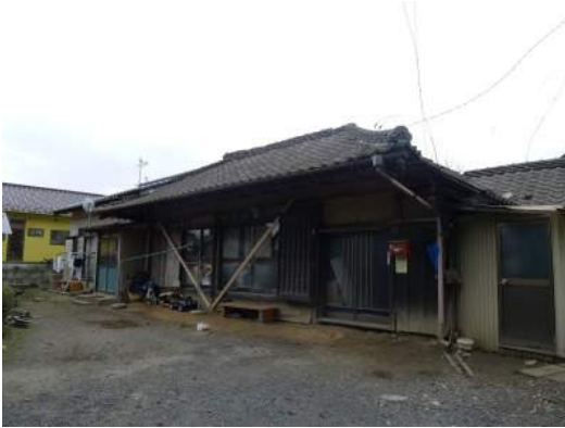
写真 5. 4. 2-5 建物外観－正面
