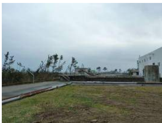
写真 6.2.5-4 建築物周辺の状況
