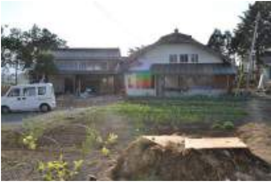
写真 7.32 被害の比較的大きい住宅 (波路上内田地区)
