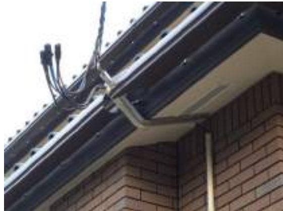
写真 5.5.1-46 雨樋の損傷
