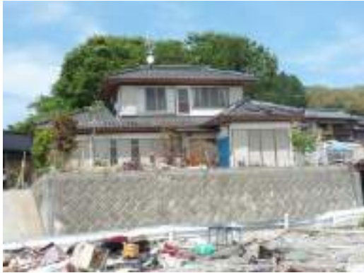
写真 10.9 赤碓町海岸付近で流失を免れた木造家屋（浸水深 6 m 以上）
