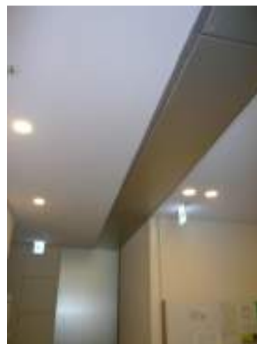
写真 5. 5. 1-50 1階エレベーター周囲の天井部分 (補修後)
