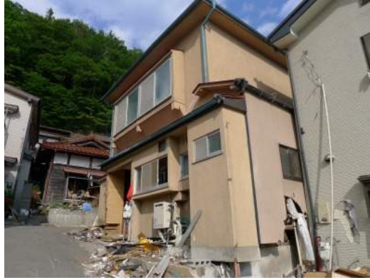
写真 4.10 基礎上端で移動した木造
