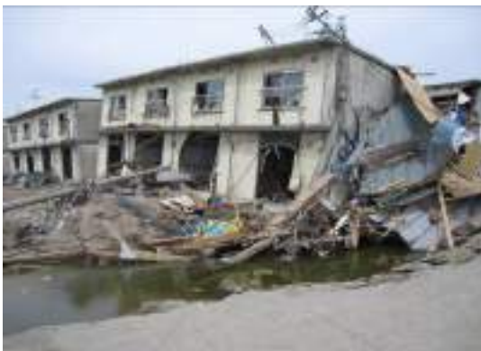
写真 6.2.6-1 周辺地盤の洗掘による傾斜
