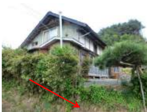
写真 7.15 M邸よりも高台に建つ木造住 宅。外観上の被害はない。
