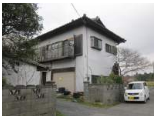
写真 5.4.2-11 建物外観、写真右側ガレージが倉庫
