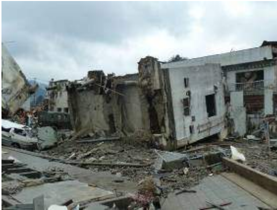
写真 6.2.3-1 建築物 東側立面
