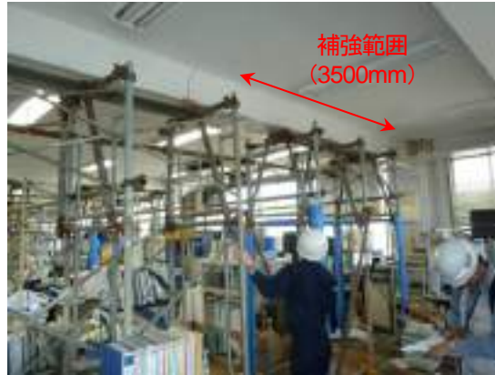
写真 5. 2. 3. 3-2 梁端の鋼板補強
