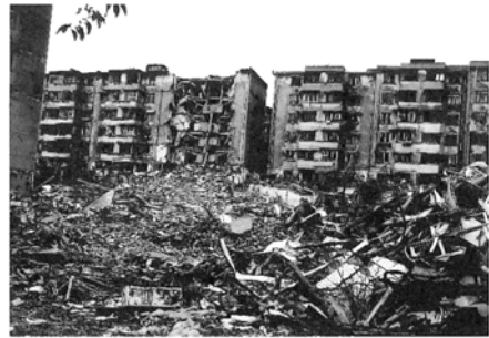
写真1 集合住宅が多数倒壊した街区 (漢旺)
