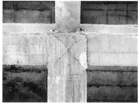
写真7 柱梁接合部の損傷
