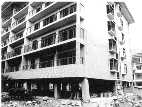
写真5 レンガ造腰壁による短柱のせん断破壊
