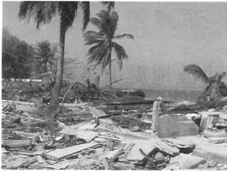
写真-1 激甚な津波被害 (Takua Pa)
