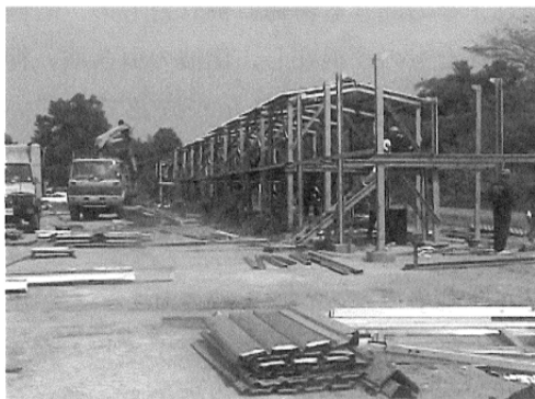
写真-3 仮設住宅建設現場
