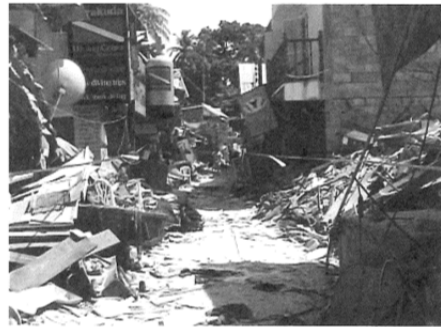
写真-6 津波で崩壊したメインストリート (Phi Phi 島)
