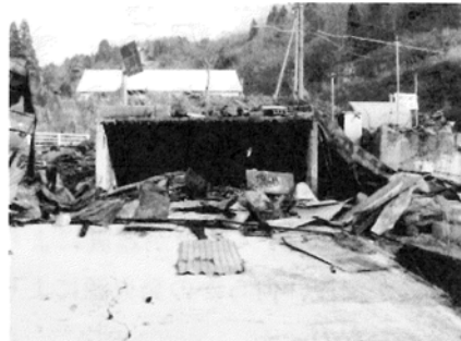
写真8 焼損した建物
