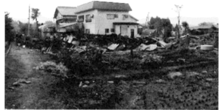
写真7 焼損した建物
