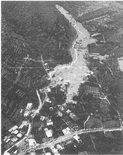
針原土石流災害直後の写真
