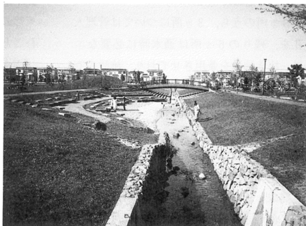
写真-1 せせらぎの回復状況(東屯田川)
