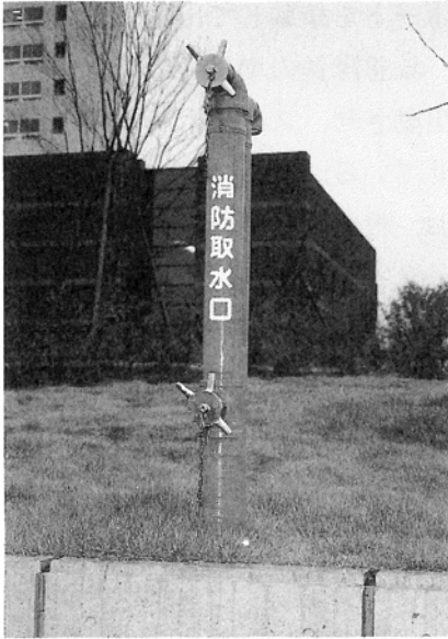
写真2 防火水槽の消防取水口
