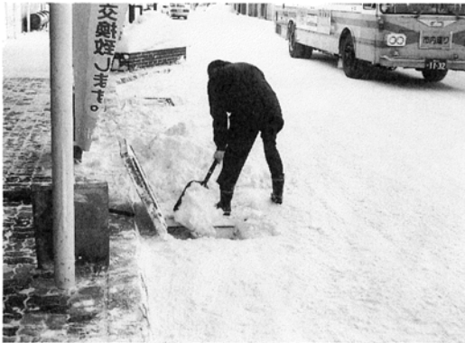
写真2 道路の排雪作業
