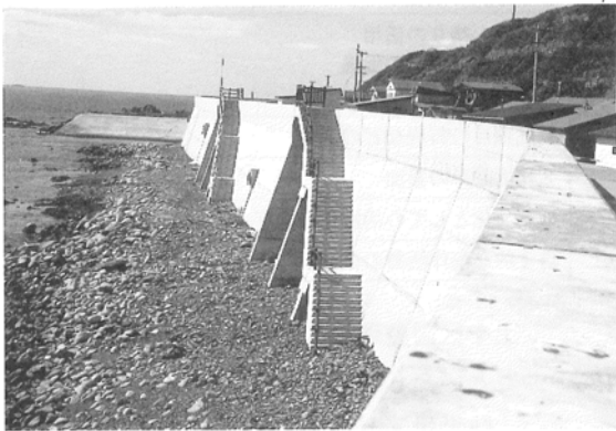
写真 2 高さ11mの防潮堤に囲まれた松江地区
