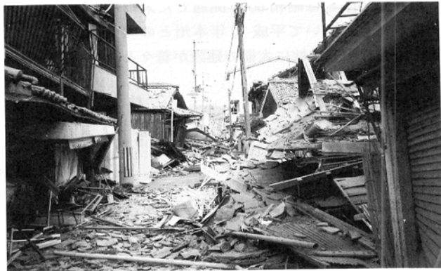
写真2 北淡町富島商店街家屋倒壊
