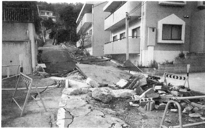
写真 4 道路の損壊状況
