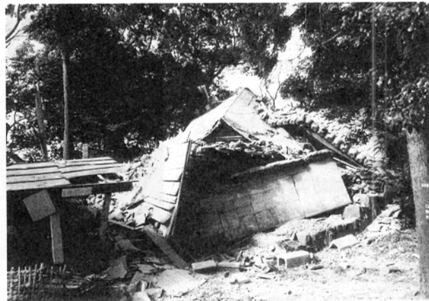
写真4 神社（重要文化財指定）の倒壊状況
