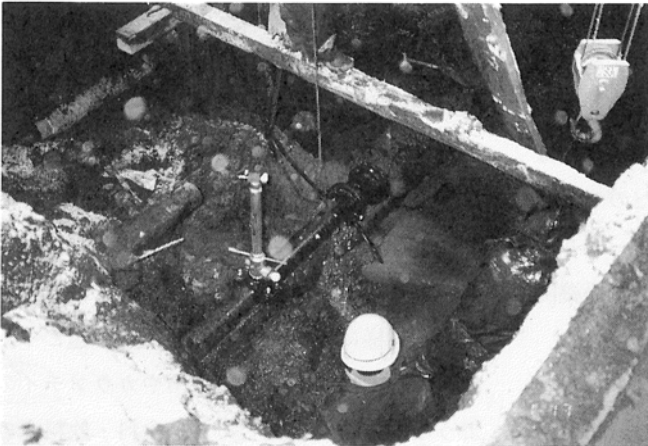
写真5 400 mm の配水管復旧作業現場
