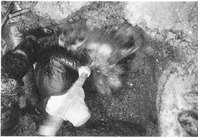
写真4 漏水復旧作業
