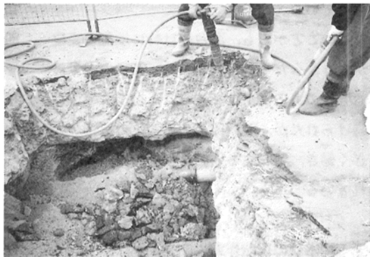
写真3 地盤の凍結状況
