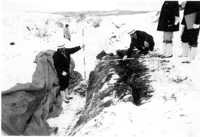
写真5 法尻のめくれ上がりの例
