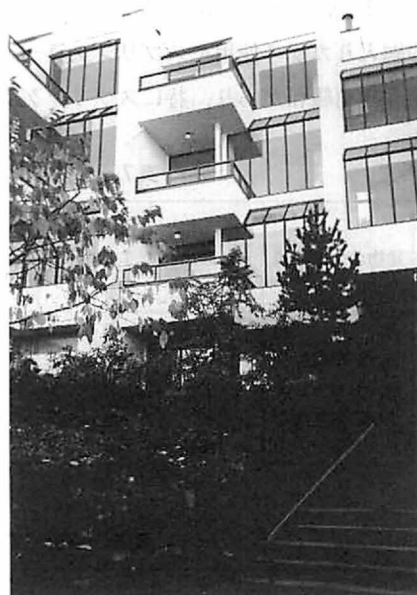
写真2 まるでRC造4階建てのような外観だが、実際には半地下と木造3階
