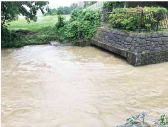
写真1 武庫川と中小河川の合流部で生じる逆流現象（2018年7月5日（西日本豪雨発生時）、地域住民が安全を確保した上で自ら撮影）
