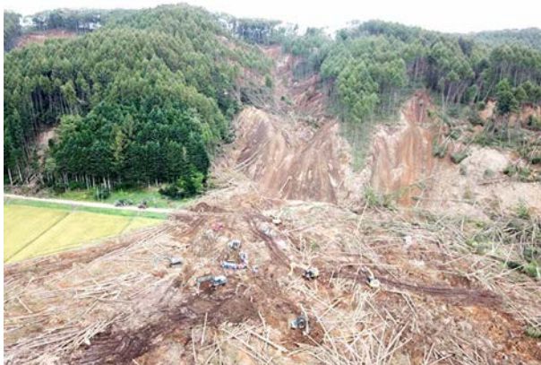
図6 幌内地区第一現場の状況
