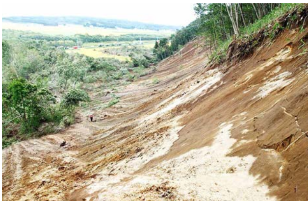
図3 吉野地区の崩壊の源頭部の状況
