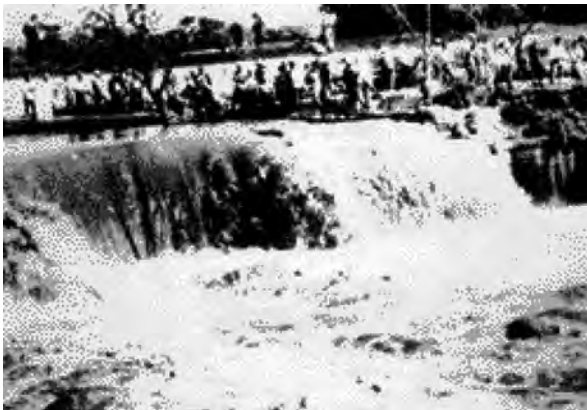
カスリーン台風災害時、濁流をみつめる住民 （東京足立区付近、関東地方整備局 HP）
