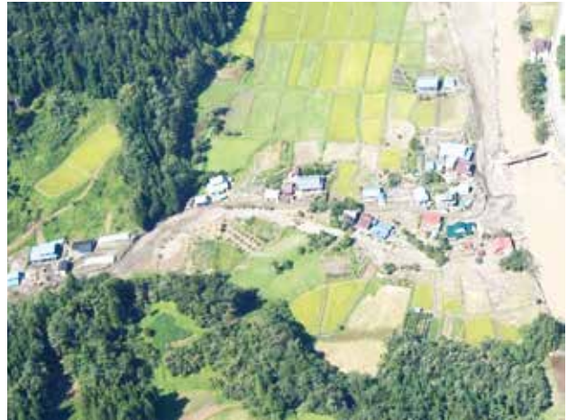
写真－2 岩泉町褰綿（ほろわた）田畑地区における集落の被災状況、右側は小本川である。左上写真は上流域の土砂流出状況（平成28年9月9日撮影）
